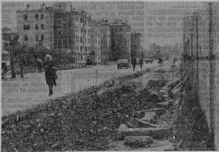
Las obras de mejora del firme de la travesía de la N-1 se llevan a cabo con gran celeridad con el fin de terminarlas en el plazo previsto. Este es un aspecto actual de los trabajos. — (Foto FEDE).
