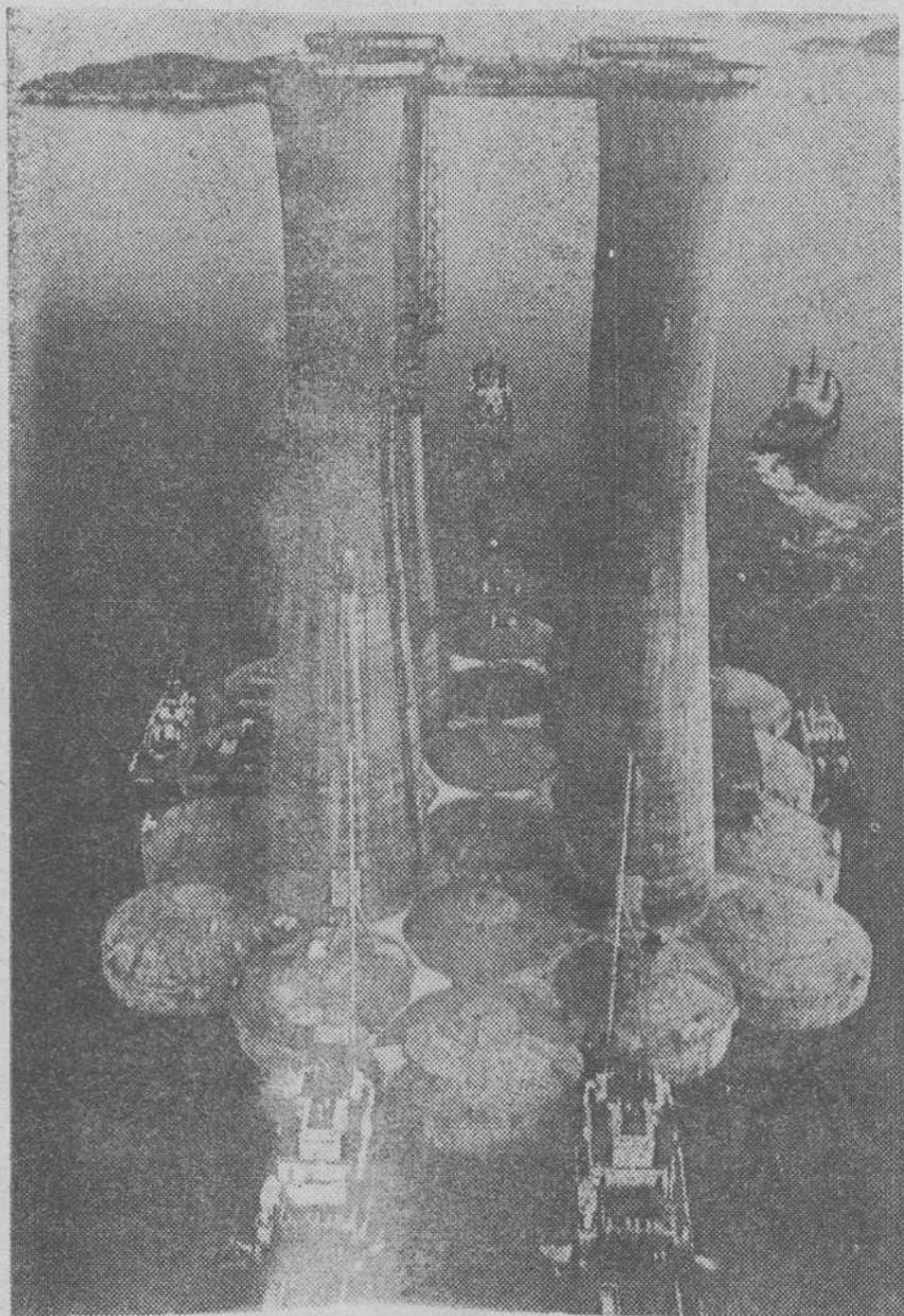
Stavanger (Noruega). — La gigantesca plataforma de Staffjord, fotografiada durante los trabajos para instalar un puente de acero a 177 metros de altura. Cuando la plataforma, la mayor del Mundo, esté terminada, medirá 271 metros de altura y tendrá un desplazamiento de 816.000 toneladas. — (Telefoto EFE-AP).
