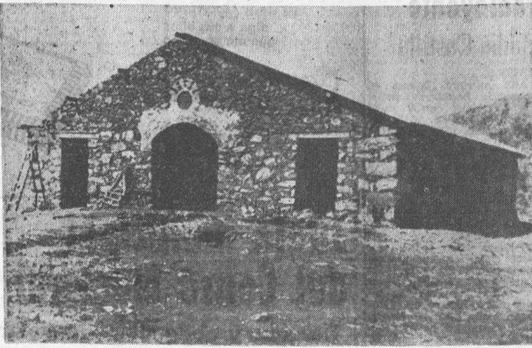
Las obras, ya casi terminadas, de la capilla-refugio de Nuestra Señora de las Nieves de Gredos que, con la autorización de la Subsecretaría de Turismo y la autorización del obispo de Plasencia se levanta en Collado Alto, a cuatro kilómetros del Castillo de Jarandilla (Cáceres) y a una hora de Guíjuelo. El proyecto se debe a don Ascensio Gorostidi y al conocido "Padre T. B. O.". — Foto Fiel
