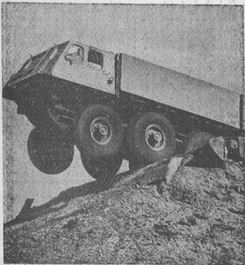
Este camión anfibio, de cinco toneladas, para todos los terrenos y de utilidad militar, ha comenzado a ser construido en serie por una firma británica. Puede salvar muros de hasta 46 centímetros y fosos de 1,50 metros; transportar cinco toneladas de carga y remolcar otras diez. En carretera alcanza una velocidad de 64 kilómetros por hora y "nada" a razón de cinco nudos. (Foto Calpe)
