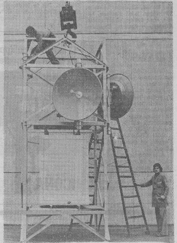
Estaciones de radioenlaces fáciles de transportar y que pueden funcionar con una fuente de energía propia. — (Foto EFE-FIEL)
