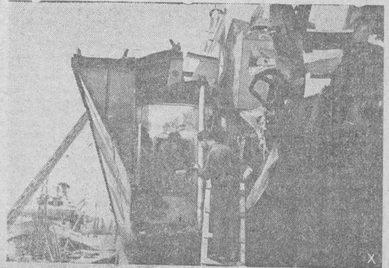
Una unidad de una escuadrilla de la Marina alemana de guerra fué deteriorada. Los daños son reparados directamente por los hombres del buque taller
