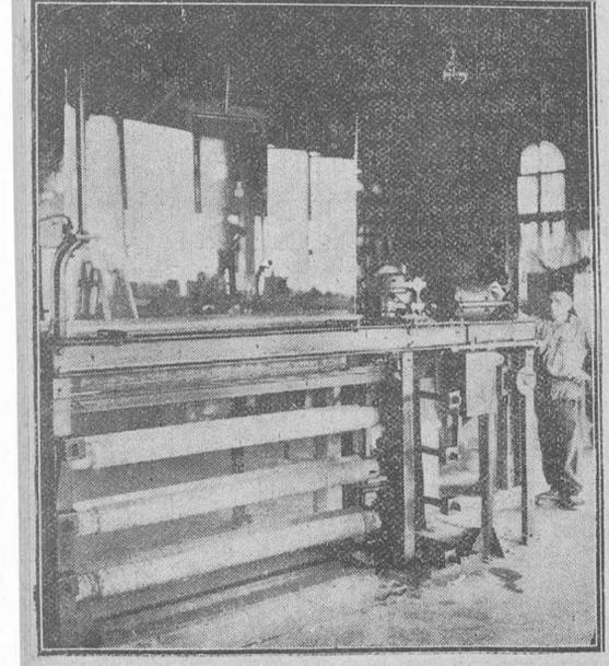
El vidrio sale, ininterrumpidamente, por cada una de las siete máquinas del horno, a velocidad variable según espesor, desde 0,30 metros a 1,20 metros por minuto.
