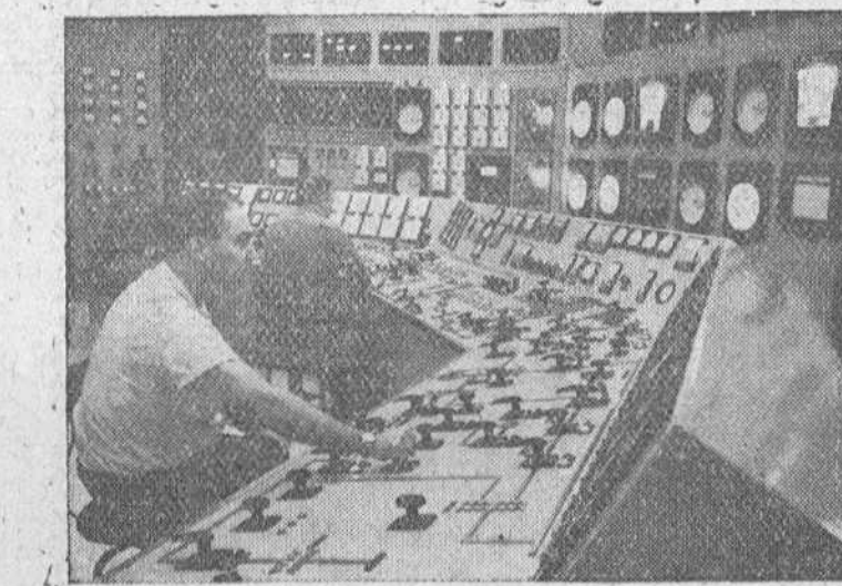
El centro que gobierna la explotación para usos pacíficos de la energía atómica se encuentra en la central atómica de Shippingport (EE. UU.). Todo el manejo del reactor nuclear, su instalación complementaria y el turbo-gerador, lo realizan estos tres operadores que se ven sentados ante los cuadros de mandos. La central atómica de Shippingport ha sido desarrollada conjuntamente por la Westinghouse Electric Corporation, la Comisión de Energía Atómica y la Duquesne Light Company de Pittsburg (Pensilvania). — (Foto Usis)
