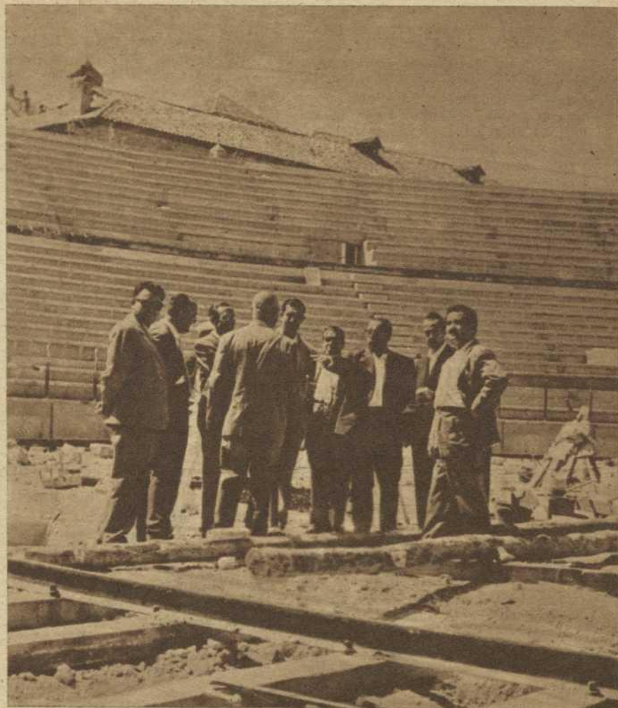
Don Pedro Balañá (hijo), durante la visita a la nueva Plaza de toros de Jaén, acompañado del alcalde de la ciudad y del arquitecto que dirige las obras (Foto Las Heras)
