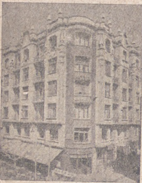
Oficinas Centrales: Espolón, 32 (Entrada por el Hondillo)
