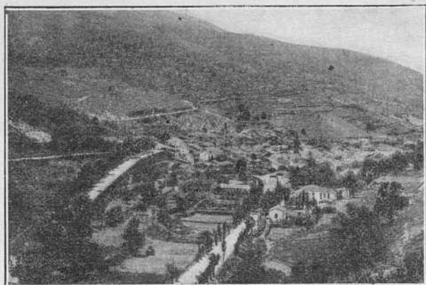
Baños de Montemayor. —Vista general.
