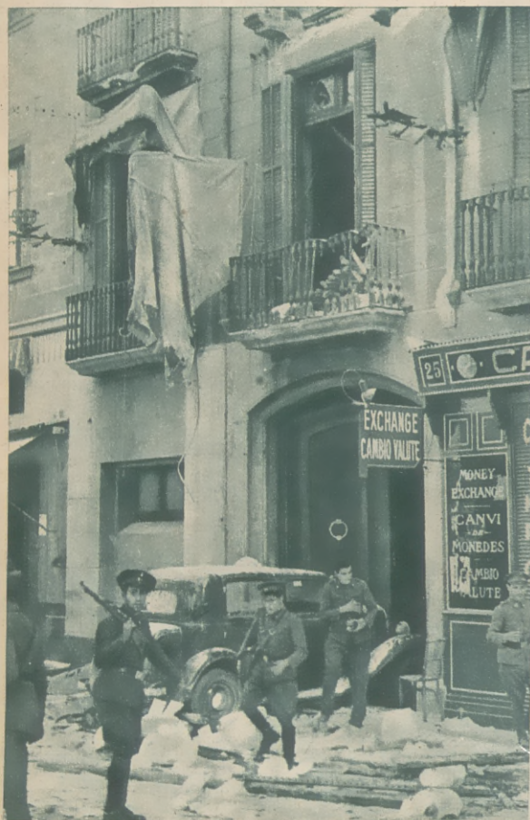
Los efectos del bombardeo en la fachada del Centro de Dependientes, uno de los edificios en que más dura resistencia se hizo a las fuerzas (Fot. Centelles)
