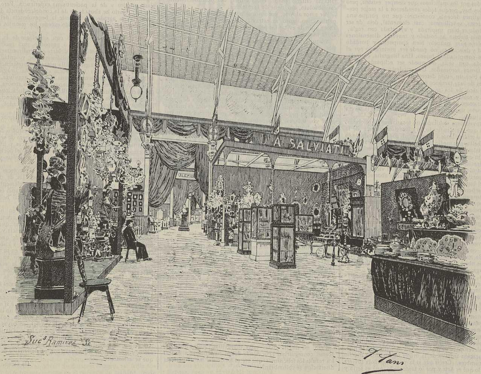
GALERÍAS ANULARES DEL PALACIO DE LA INDUSTRIA
