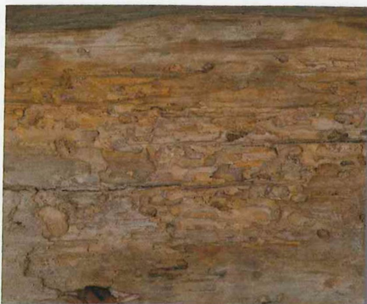
Viga atacada por insectos xilófagos. En los tratamientos deben tomarse las precauciones oportunas para no perjudicar a los murciélagos presentes.
