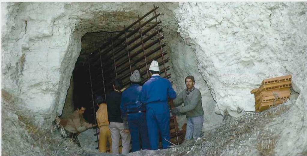
Colocación de un enrejado especial para murciélagos, con el fin de evitar el vandalismo que se producía en un refugio.
