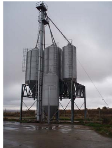
Figura 3. Silos exteriores de recepción de pienso
