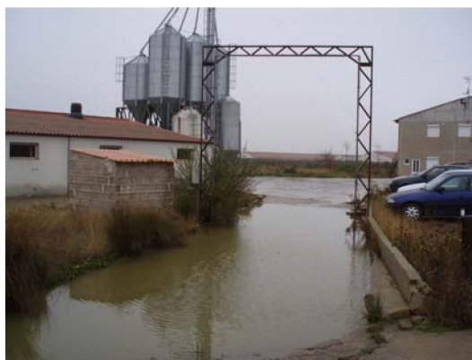
Figura 2. Vado sanitario y arco de desinfección.
