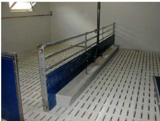
Figura 6: Separaciones interiores de un cebadero
