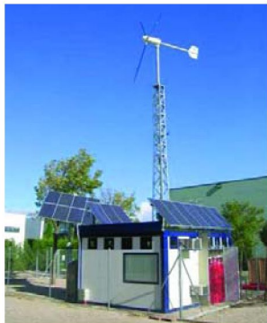
Instalación de Proyecto Aeropila.
