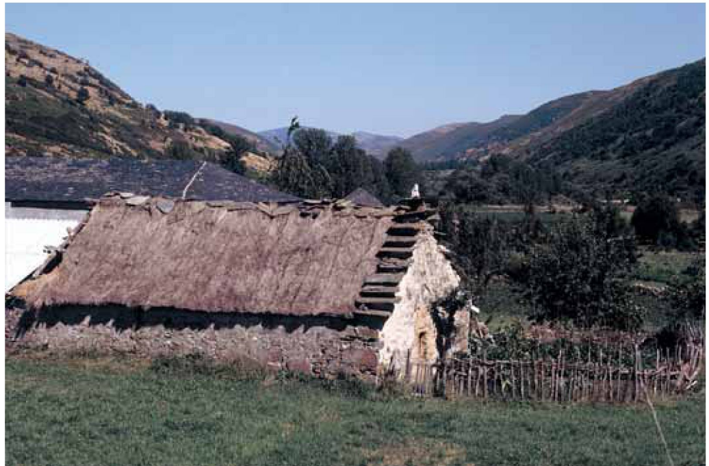
Torrecillo (Murias de Paredes). En los pueblos de la Omaña Alta aún se conservan casas cubiertas con el techo, o techo de paja de centeno, y los decorativos y singulares remates escalonados con lajas de pizarra. Al fondo, el ancho perfil del Valle Gordo. (Foto: Alipio J. García de Celis).
