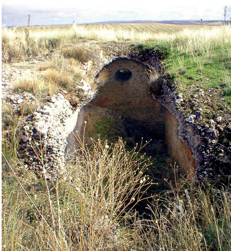
La cisterna sur antes del inicio de los trabajos
