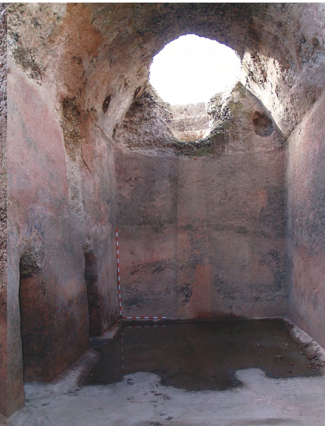
Interior de la cisterna norte
