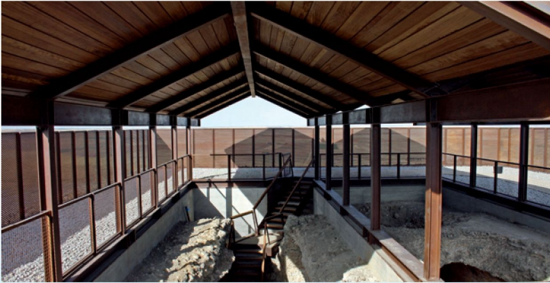
Estado actual de las cisternas con la cubierta de protección. Abajo, sección transversal con el edificio incorporado
