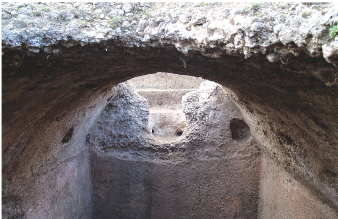
Cubierta abovedada de la cisterna norte
