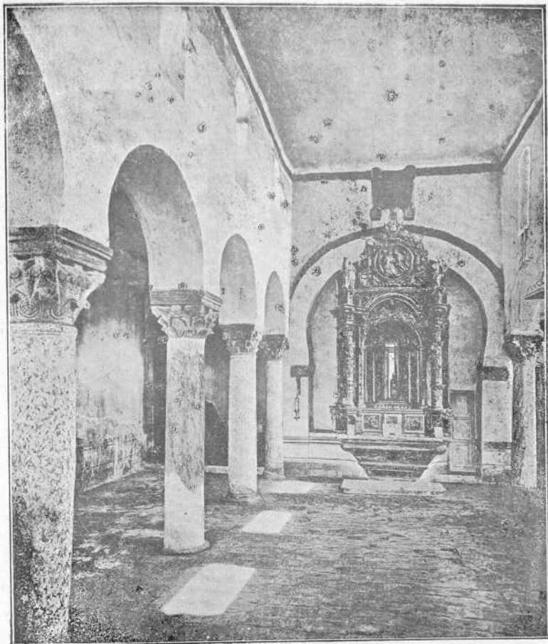
BASÍLICA DE SAN JUAN BAUTISTA INTERIOR, ANTES DE LAS OBRAS
