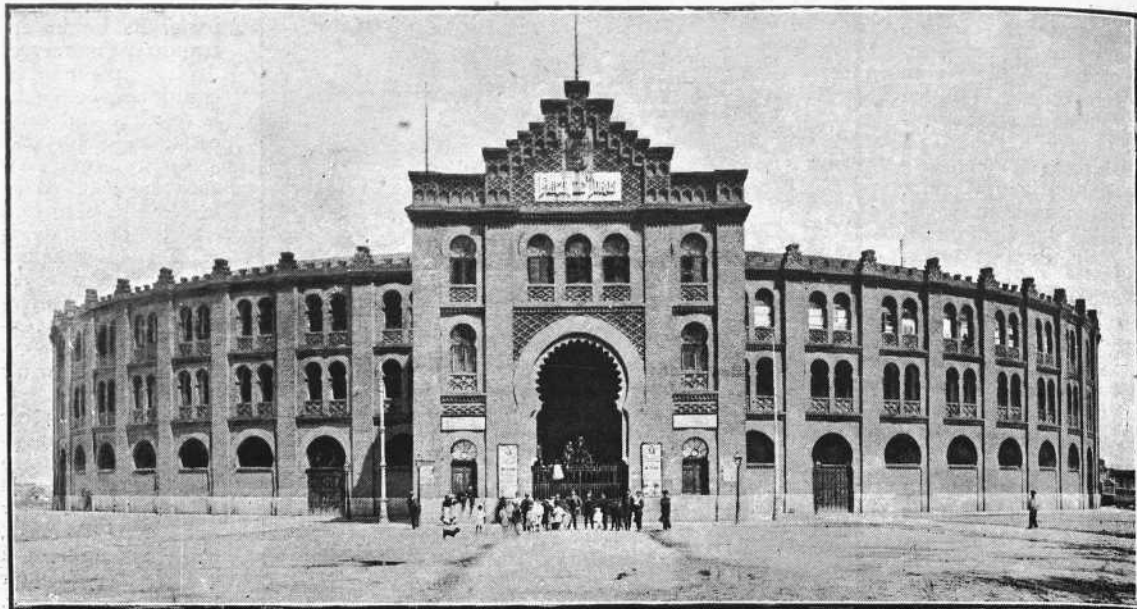
VISTA EXTERIOR DE LA PLAZA
