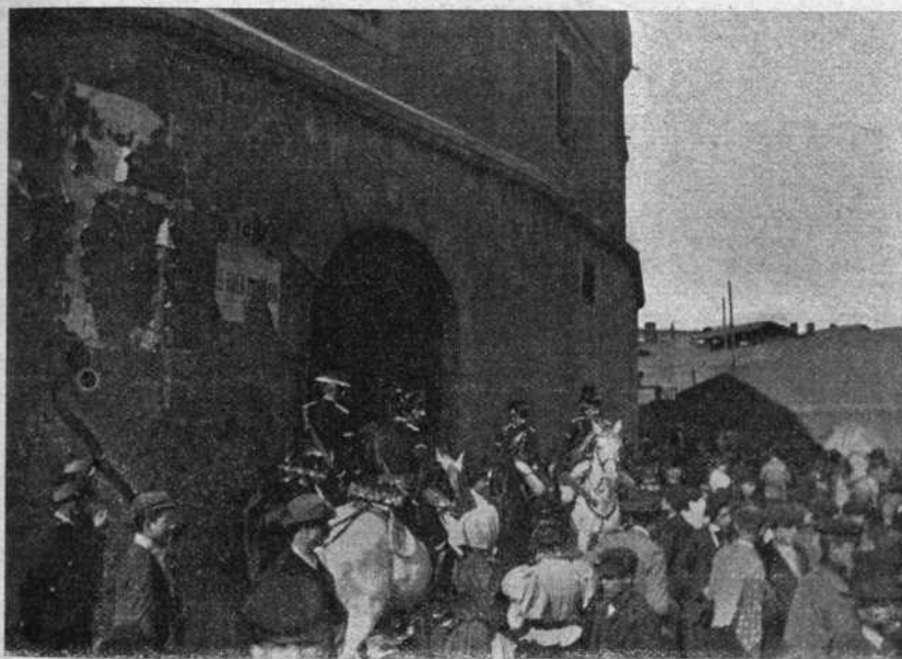
Vista exterior. Puerta de arrastre. El público esperando á las cuadrillas.
