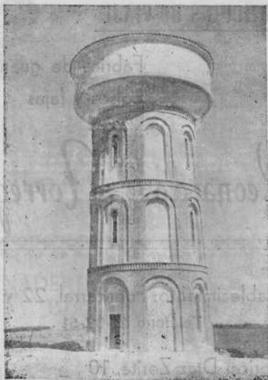
Depósito elevado para abastecimiento de agua con capacidad de 300 metros cúbicos
