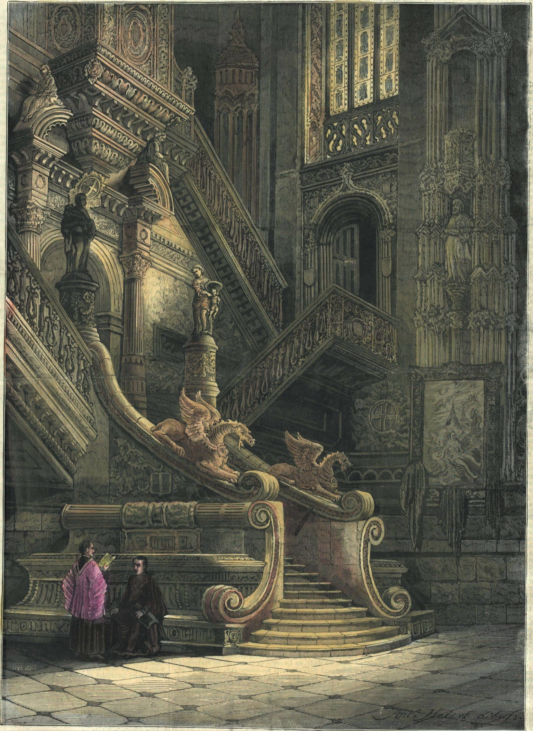
BURGOS.—ESCALERA DE LA «PUERTA ALTA» Ó DE LA «CORONERÍA», EN LA CATEDRAL.
