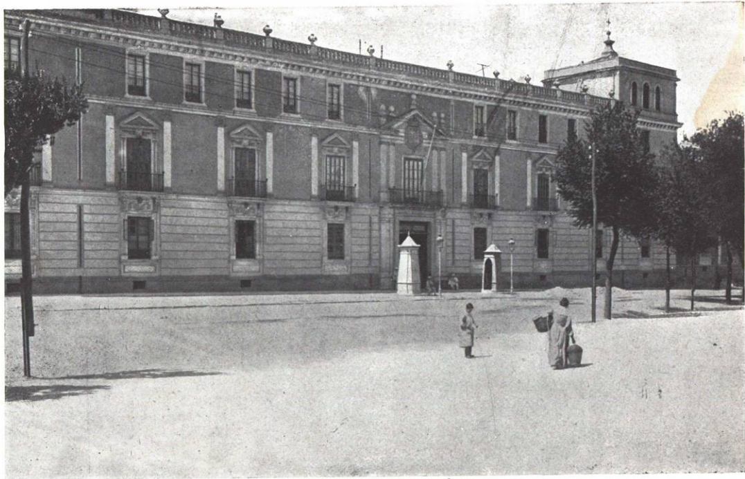
Ocupa el antiguo Palacio Real, edificado á principios del siglo xvii, en cuyo patio principal se observan dos órdenes de galerías estilo Renacimiento
