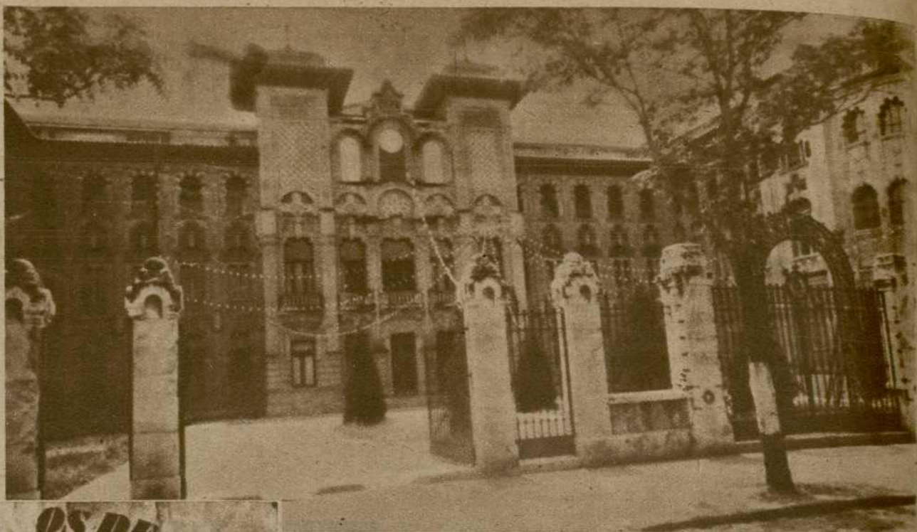
Edificio de la Facultad de Veterinaria de Córdoba, donde se está terminando de instalar la Exposición de Arte Taurino
