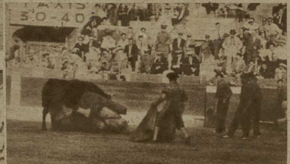
Caida peligrosa de un picador
