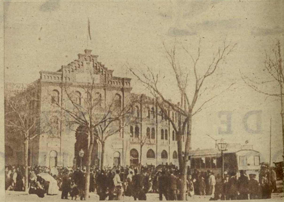
Vista de la desaparecida Plaza de Toros madrileña de la carretera de Aragón
