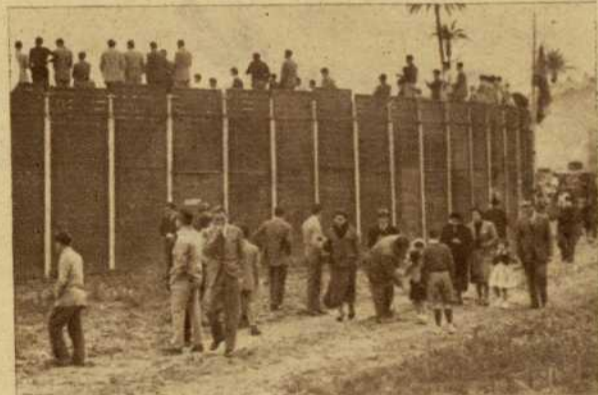
ALCANTARILLA.—En un ambiente de paisaje bíblico, con penachos de palmeras, se halla la Plaza portátil, situada en plena huerta (Foto López)
