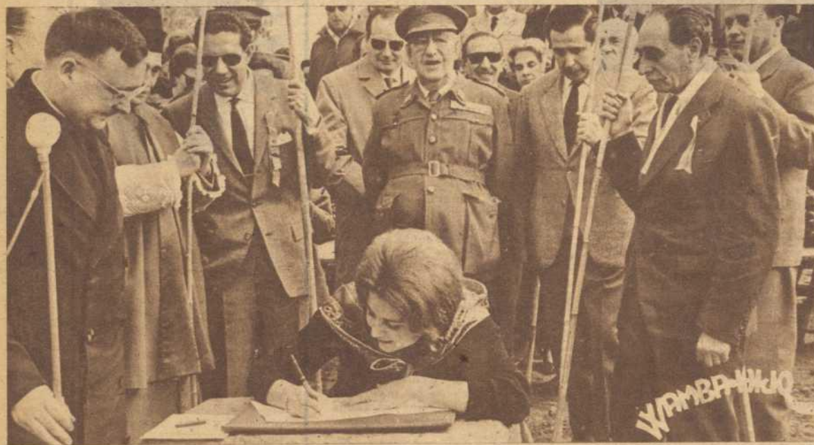
La ceremonia de colocación de la primera piedra del nuevo Seminario de la recién creada diócesis Segorbe-Castellón. La Reina de la Fiesta, señorita Conchita Torres Puya, estampó su firma en el acta en presencia de las autoridades
