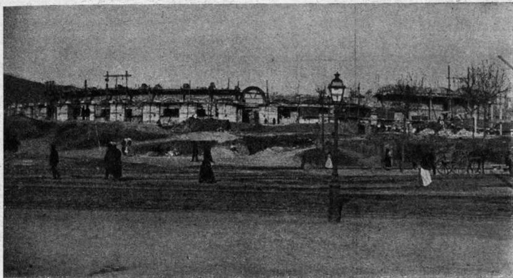
Enero de 1900.—Vista exterior de la plaza.
