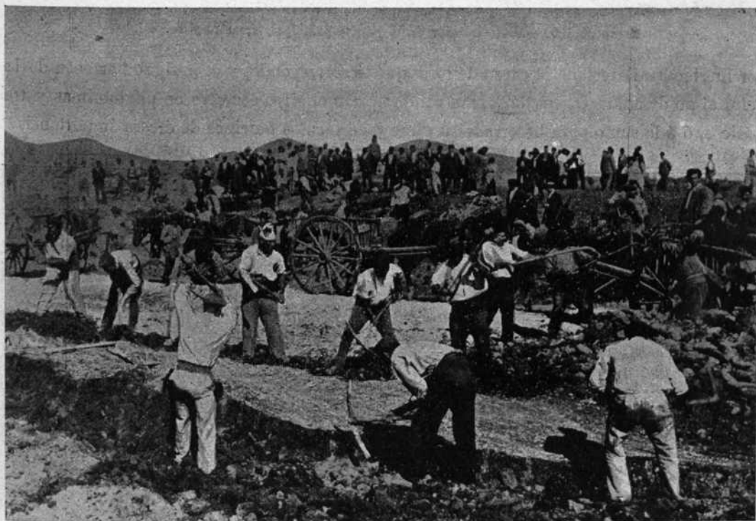
Octubre de 1899.—Comienzo de los trabajos: desmonte de terrenos.
