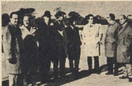
PLANA MAYOR.—Sobre el terreno de la Venta se sigue la marcha de las obras.
