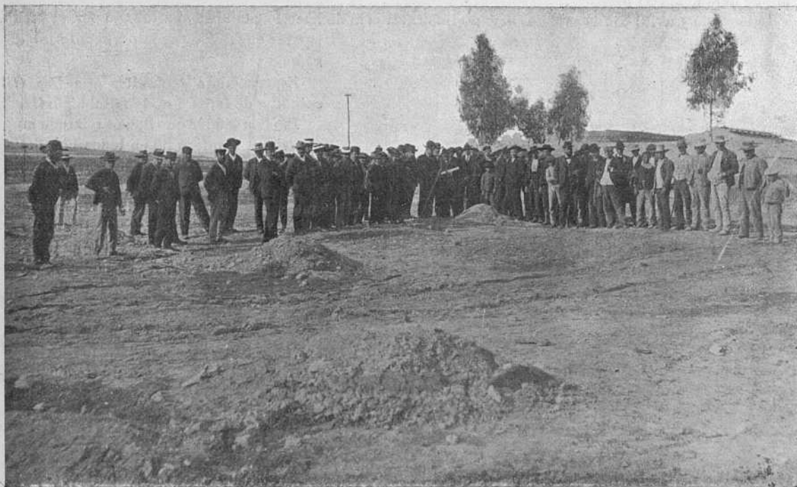
COMISIÓN ORGANIZADORA, ARQUITECTO, SU AYUDANTE Y VARIOS AFICIONADOS, MOMENTOS DESPUÉS DEL REPLANTEO Y COMIENZO DE LOS TRABAJOS EN LA PLAZA DE TOROS
