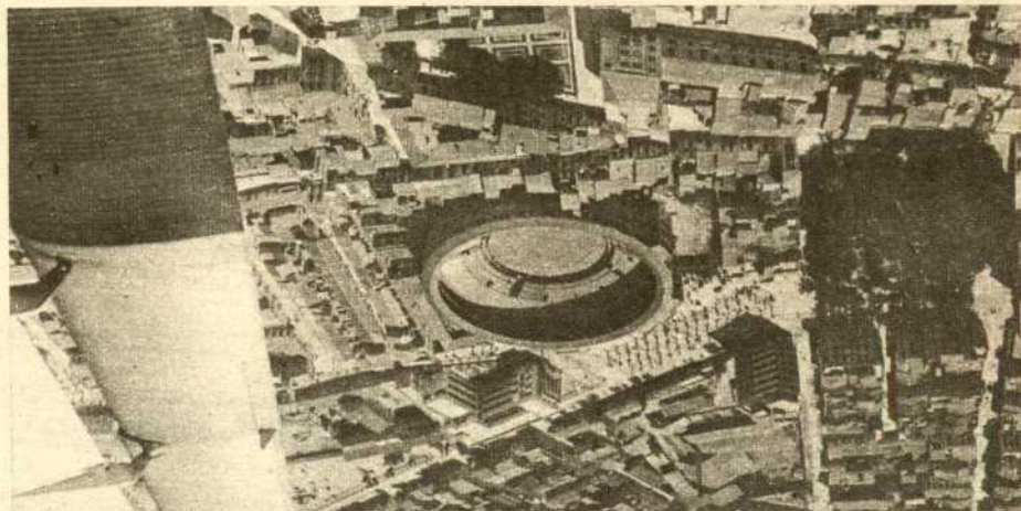
Vista aérea de la actual plaza de toros de Alicante. Como se observa, está ubicada en el corazón de la ciudad.
