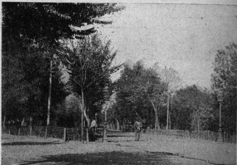
Entrada al paseo de la Taconera.
