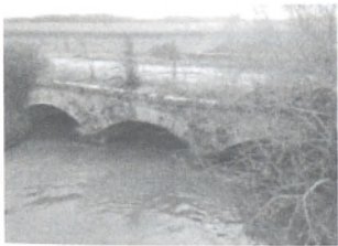
Antiguo puente de La Aldea. Fotografía: Pedro M a Caballero Lozano.
