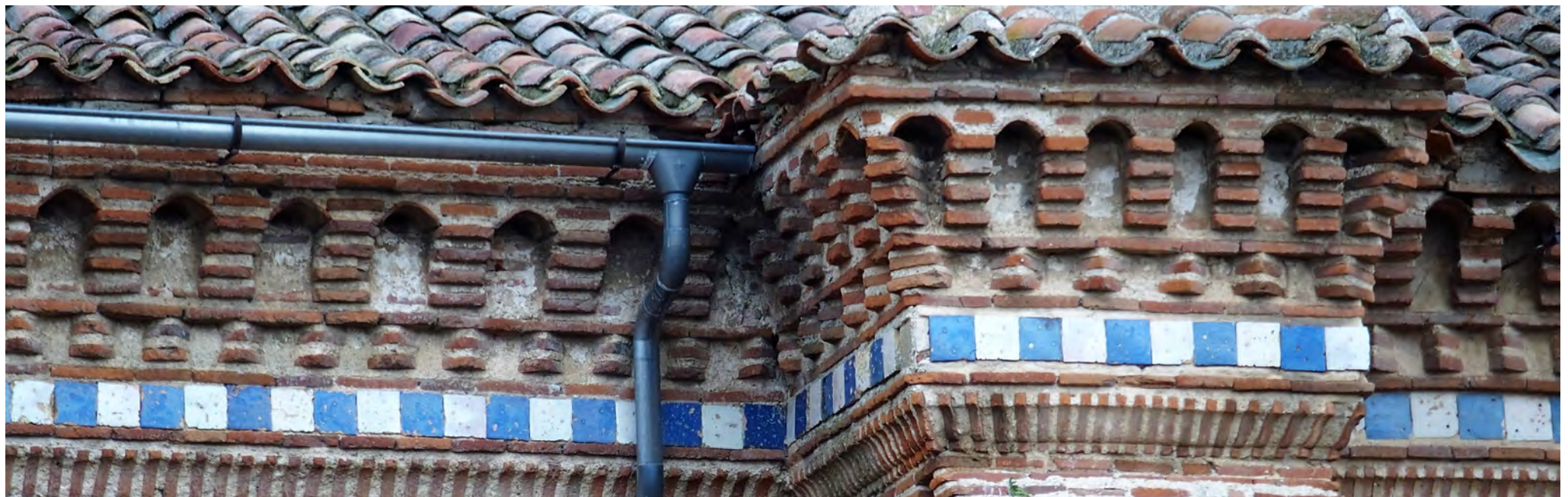
Vista parcial de la fachada sur de la iglesia y detalle de la greca de azulejos
