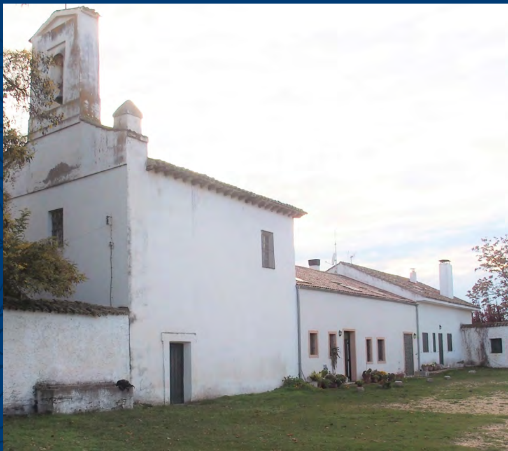
Capilla de la Casa de la Vega de Porras, Boecillo. Valladolid
