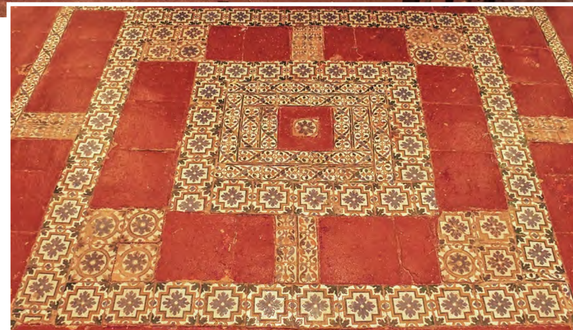
Vista de la solería dispuesta en la capilla mayor y detalle de los motivos utilizados
