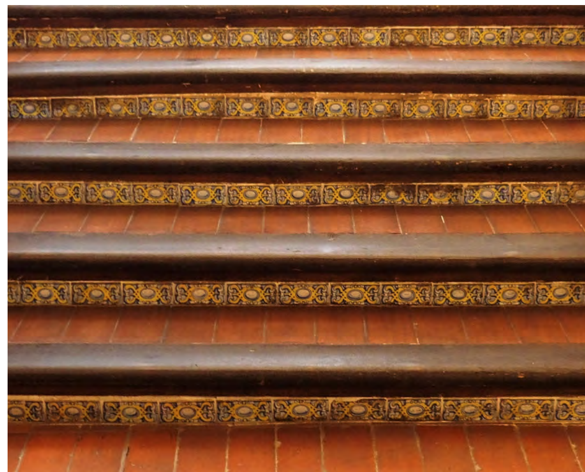
Vista general de un tramo de las escaleras del claustro
