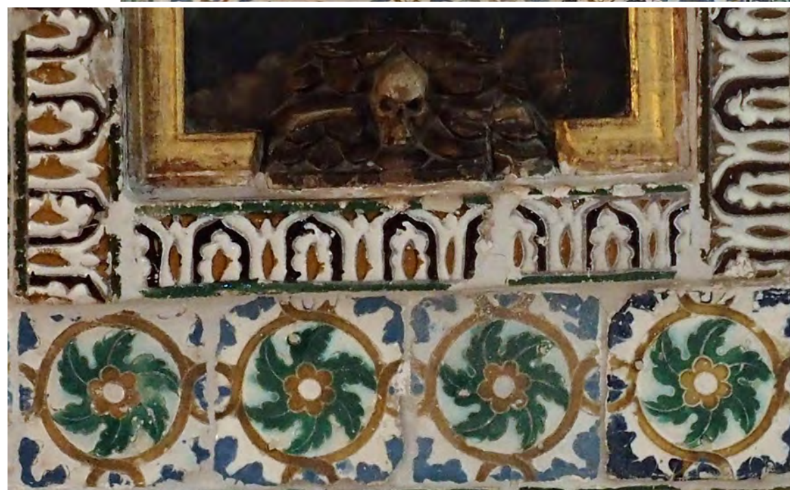
Vista del frontal del Cristo de la escalera y detalle de los alízares de cuerda seca que lo enmarcan
