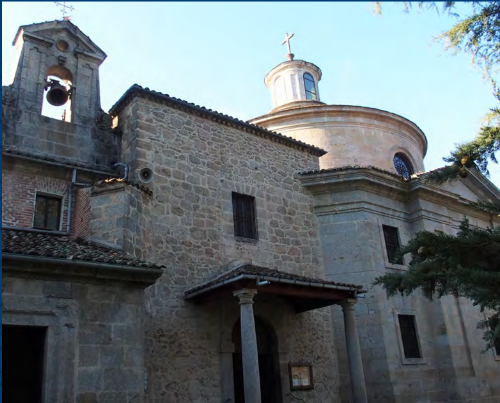
Vista de la iglesia y de la Capilla Real del santuario de San Pedro de Alcántara, Arenas de San Pedro. Ávila
