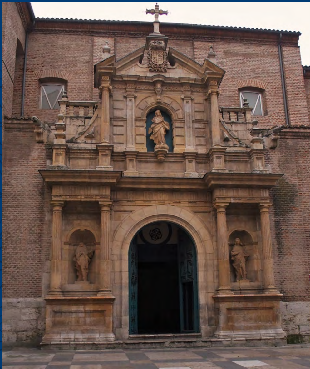
Vista de la portada de la iglesia del ex convento de Santa Cruz de Comendadoras de Santiago, Valladolid
