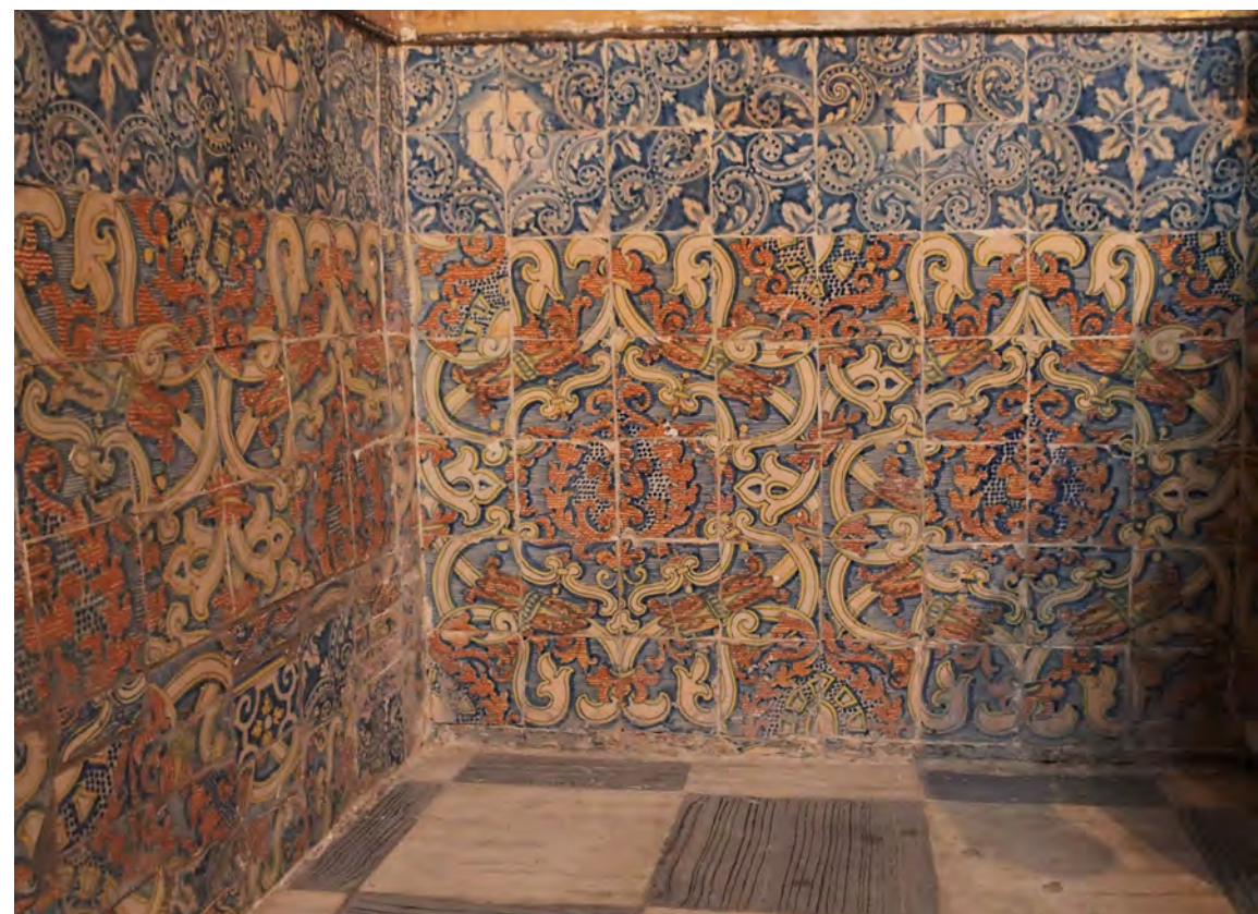
Detalle del zócalo de la capilla del Relicario
