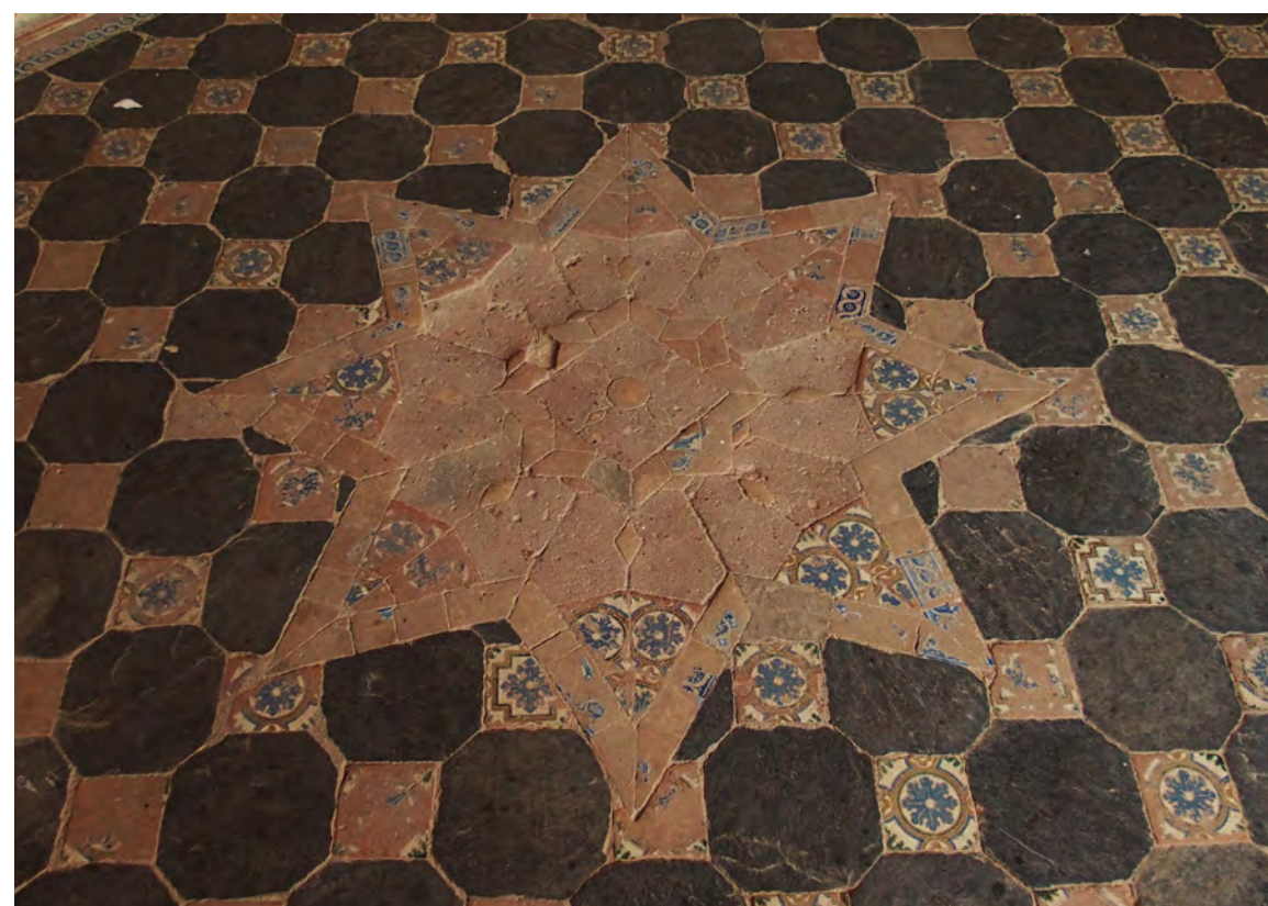
Vista del pavimento del camarín y detalle de la estrella de azulejos colocada en el centro
