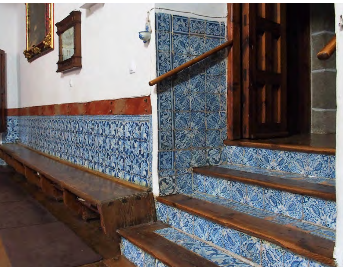
Detalle del zócalo y escaleras del coro bajo de la clausura
