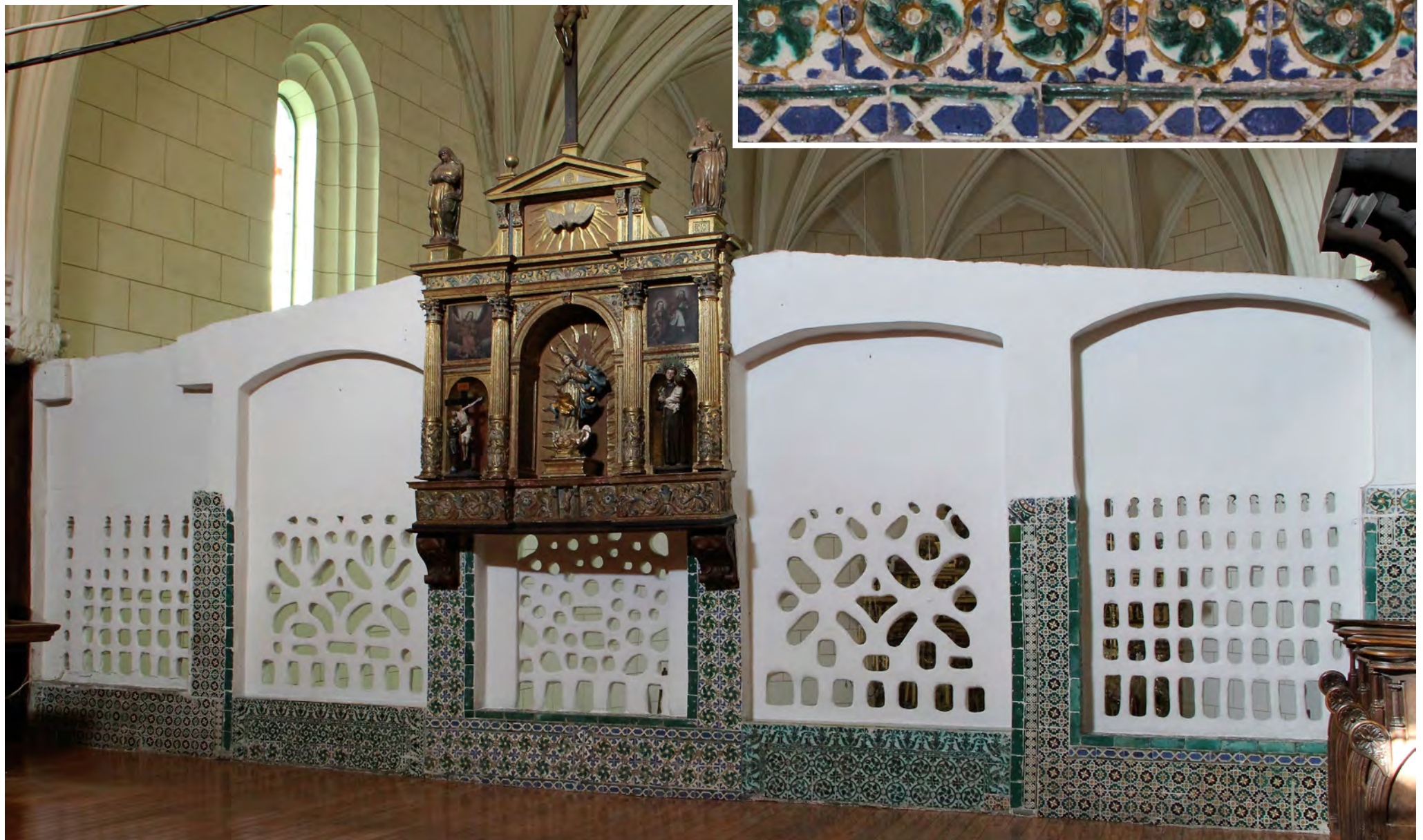
Vista del zócalo de la celosía de cierre del coro alto y detalle de su tramo central
