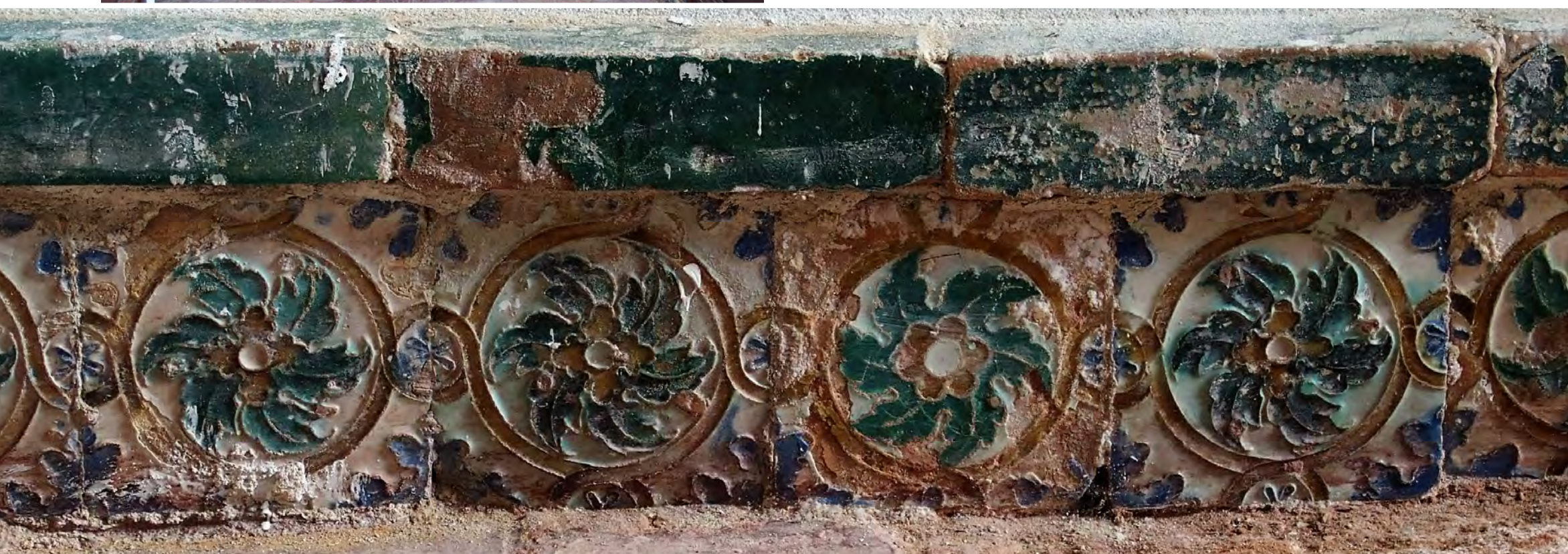
Vista de la capilla del Cristo y detalle del rodapié original
