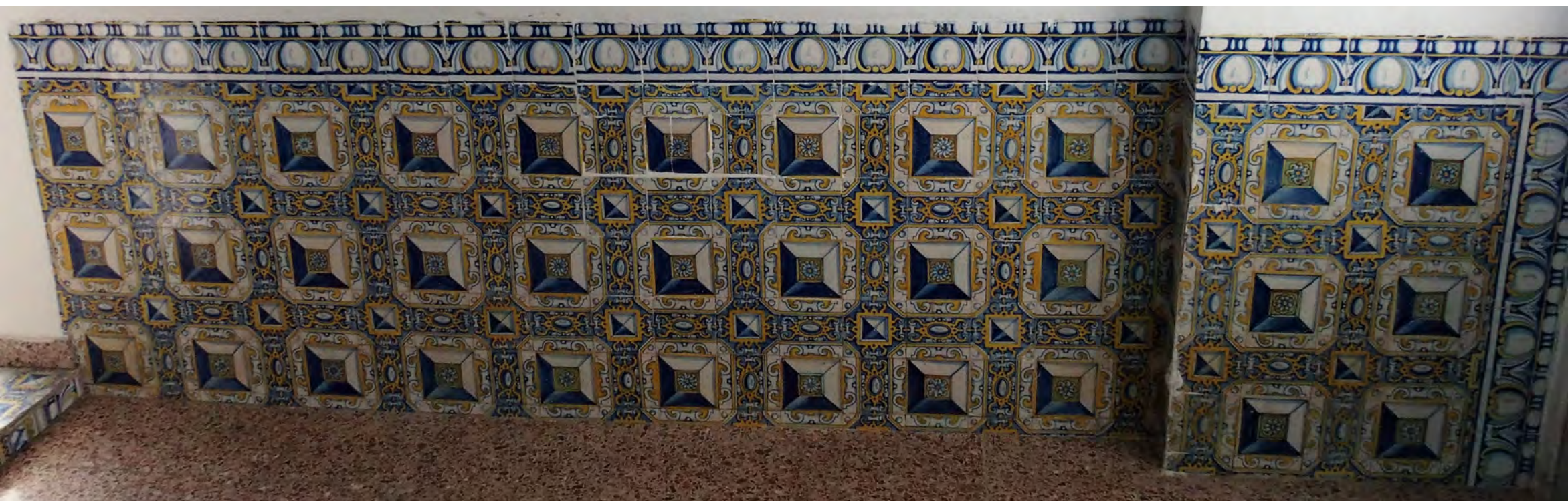
Detalle del arrimadero de la capilla de la Soledad
