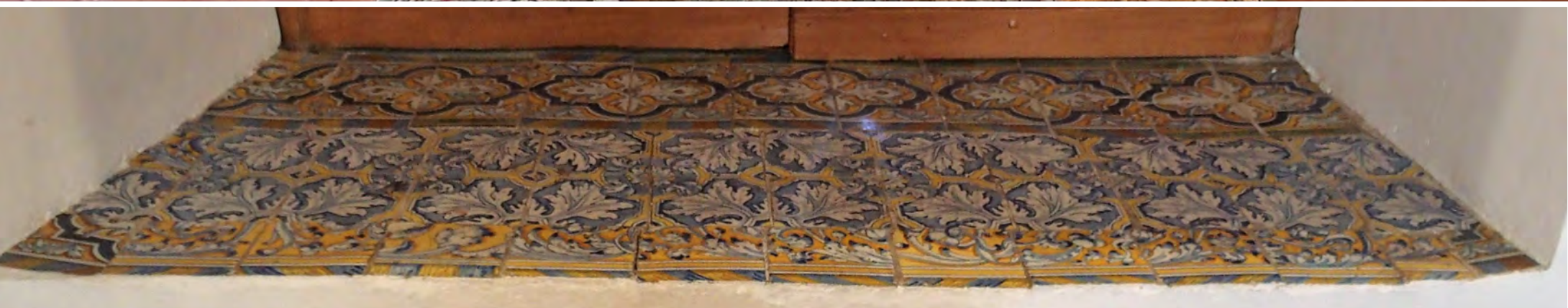
Vista de la celda de Santa Teresa y detalle de uno de los alfeizares
