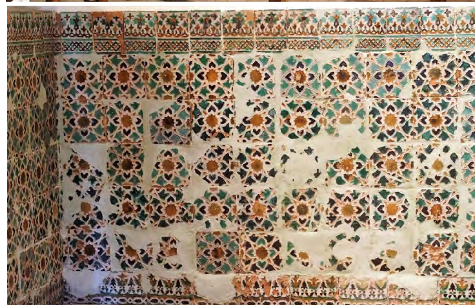
Vista de uno de los ámbitos de la "Casa del Alcaide" y detalle de los azulejos del zócalo
