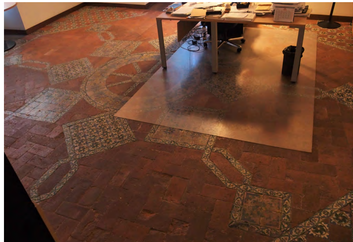
Vista general del suelo del despacho de la primera planta de la torre
