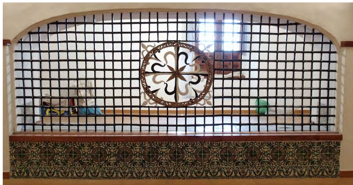
Vista de los azulejos del zócalo de la reja del locutorio grande
