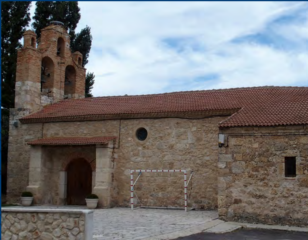
Iglesia de San Andrés, Torre de Peñafiel. Valladolid
