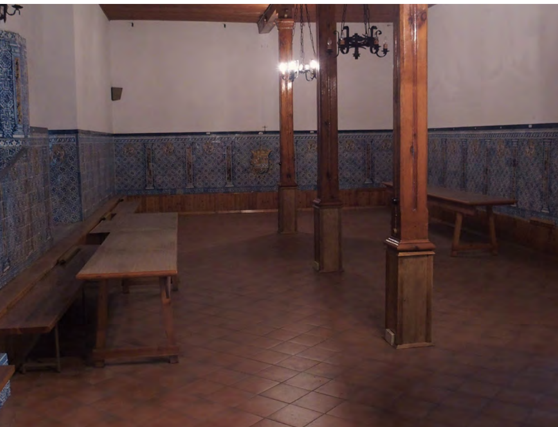
Arrimaderos de azulejo del refectorio
