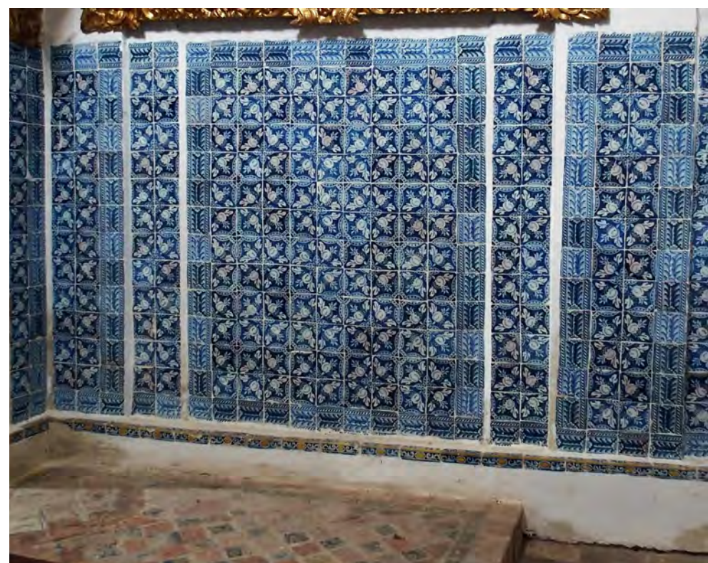
Detalle de los arrimaderos y los azulejos dispersos por el pavimento
