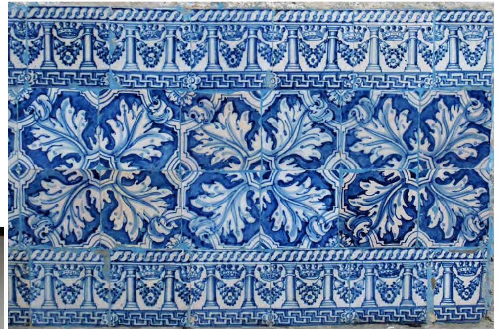
Vista de una de las pandas del claustro bajo y detalle de la obra de azulejería del zócalo del muro de cierre
