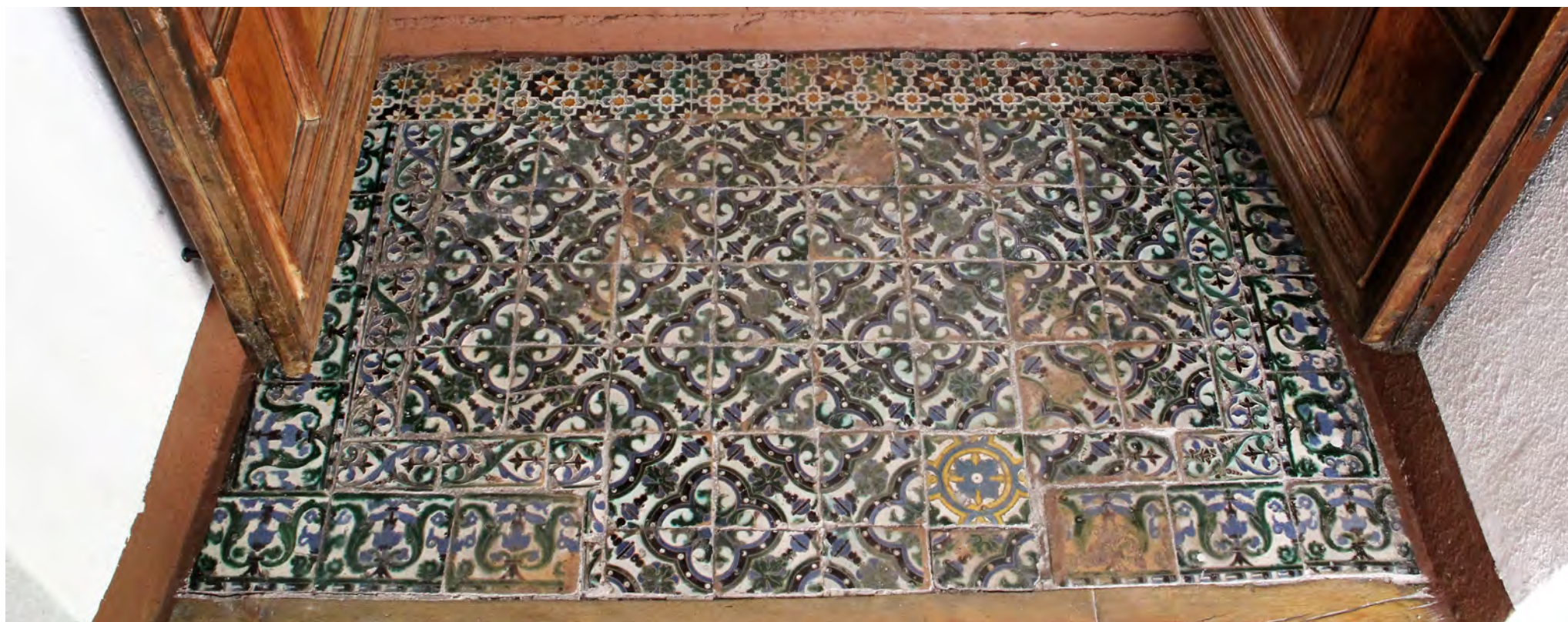
Vista del pavimento en el acceso al coro alto
