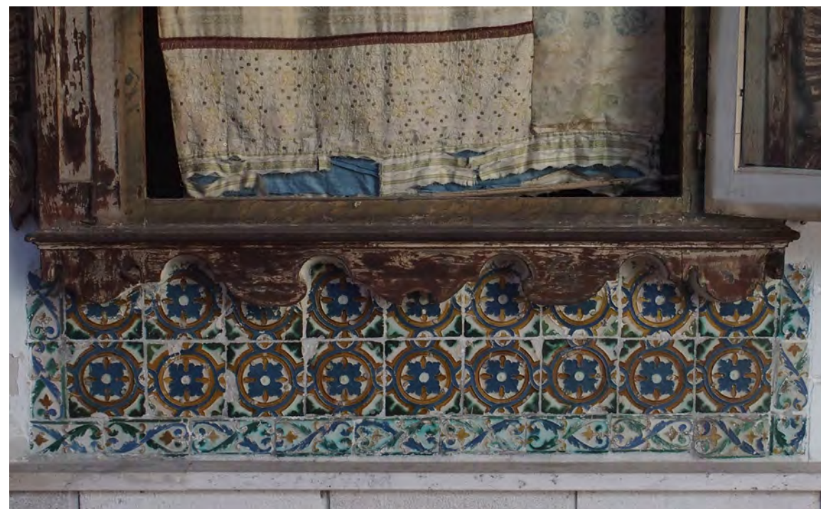
Detalle del frontal de la hornacina junto a la capilla del Cristo
