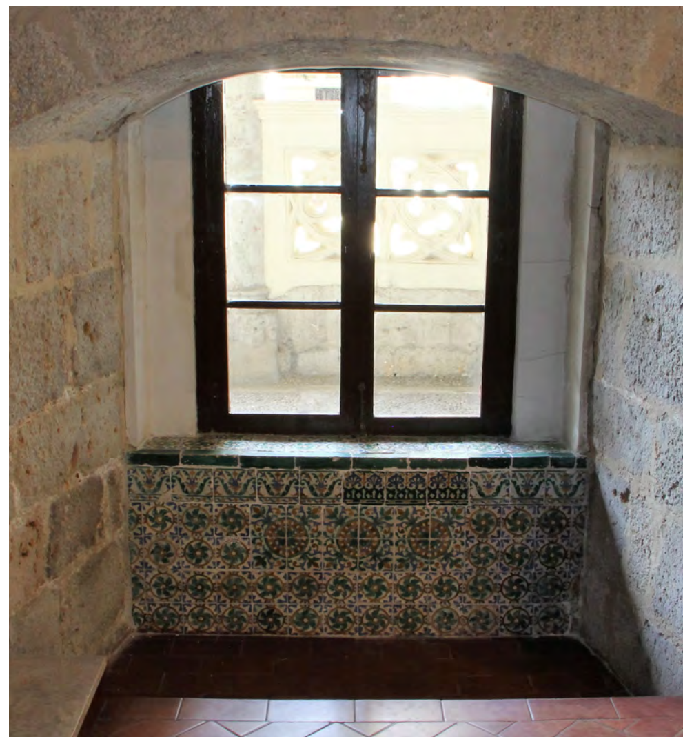
Vista del zócalo de la ventana de la antigua capilla de Belén
