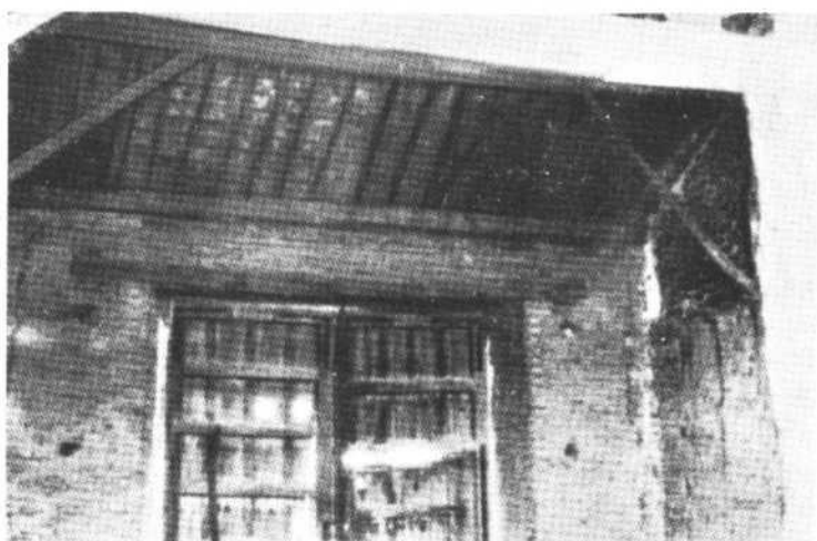
Fig. 7.—Sobre la trascera se aprecia el cabecero . (Vid. este término en el Vocabulario general .)
