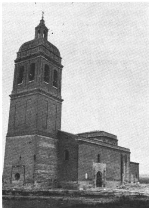
Rodilana. Iglesia de San Juan Bautista, reconstruida en el segundo tercio del siglo XVI. Esbelta torre con gran cuerpo de campanario.
