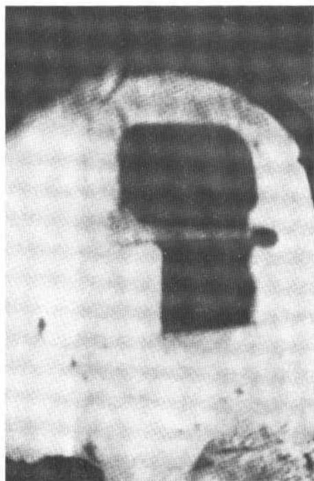
Fig. 39.—Muy pocos ejemplares quedan ya del horno de Perigüelo (de Pereruela), de pequeño tamaño y con campana prefabricada de barro refractario, que recuerda a una tinaja.
