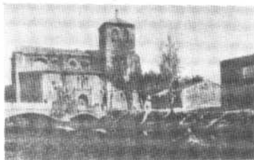
Medina del Campo. Puente de San Miguel
