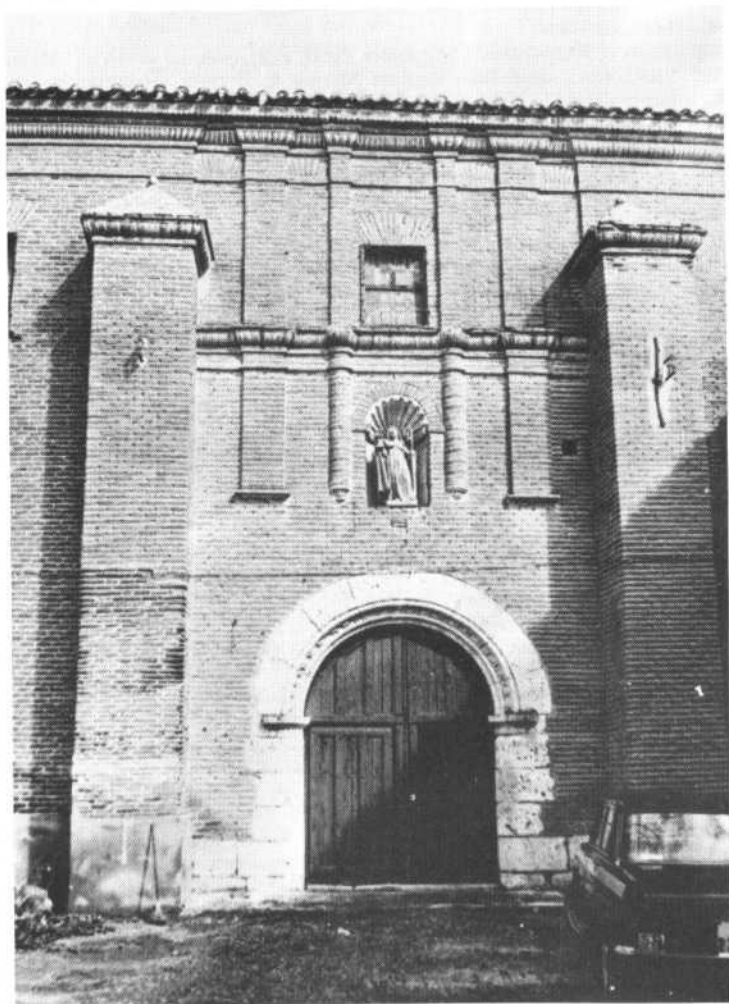
Portada de la iglesia del convento de Santa Clara de Madres franciscanas, fundación patrocinada por Fernando III el Santo. Se debió reconstruir en 1732.
