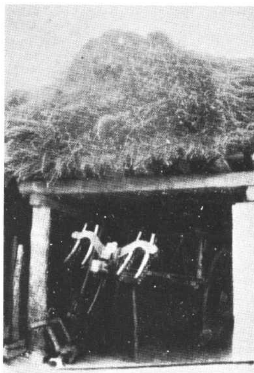
Fig. 6.—La tinada , con su característica cubierta de manojos: haces de sarmientos.
