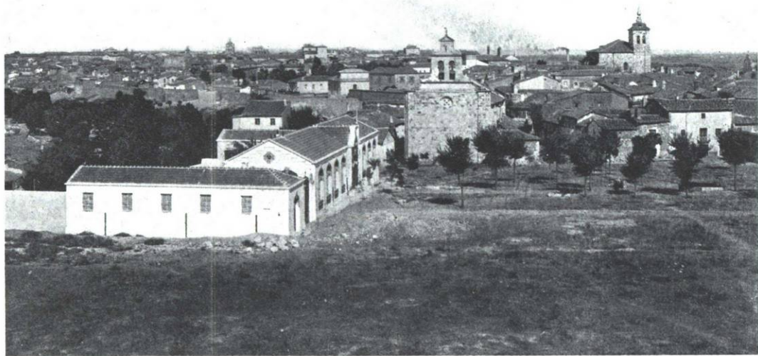
Del compacto grupo que forman sus edificios particulares, sobresalen particularmente los de carácter religioso, con sus torres campanarios, entre los que se destacan los de San Isidro y de la Catedral.
