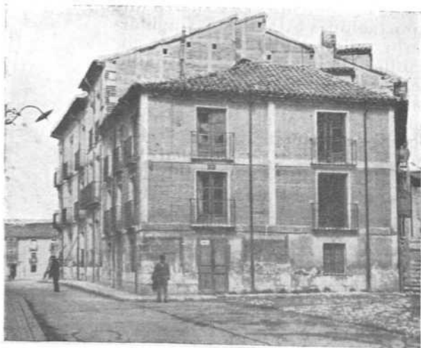
Las tres casas adquiridas para la ampliación del Grupo escolar "Isabel la Católica".
