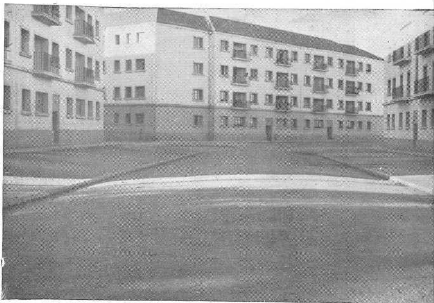
Calle de los Reyes Católicos (viviendas protegidas), después de ser pavimentada.
