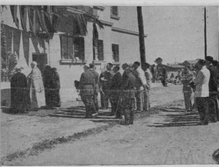
Bendición del Grupo de Viviendas protegidas "Onésimo Redondo"
