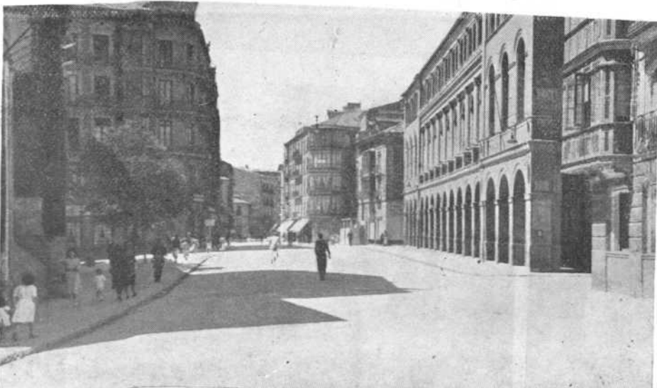
Calle de las Angustias después de pavimentada y levantadas las vías.
