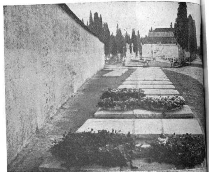
CONSTRUCCION DE NUEVAS SEPULTURAS
