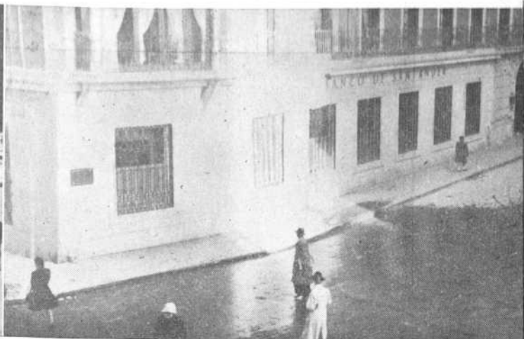
Después de pavimentada en el encuentro con la calle de Santiago y ser modificada la acera.
