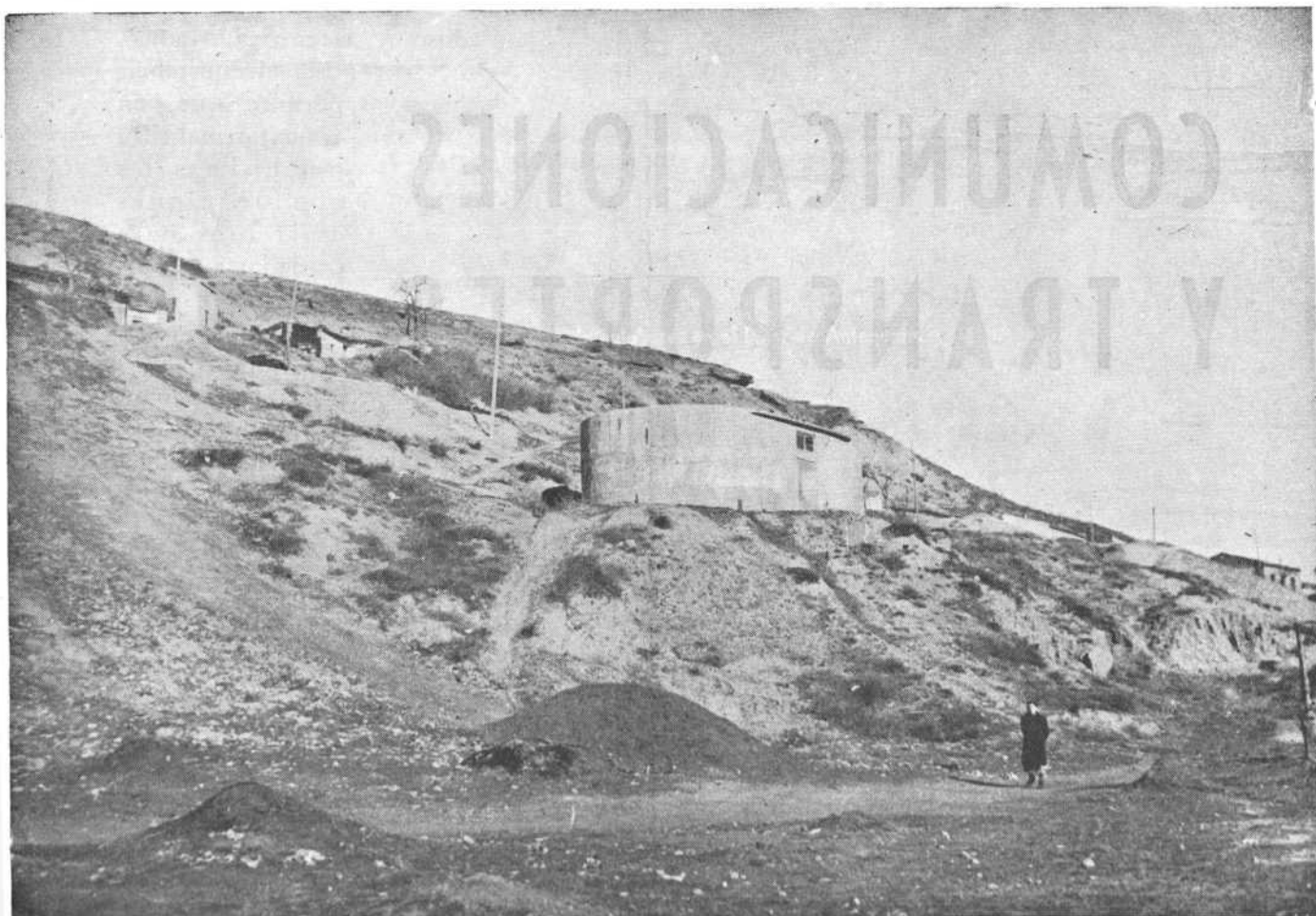
Depósito de agua construido por el Ayuntamiento en la Cuesta de la Maruquesa.
