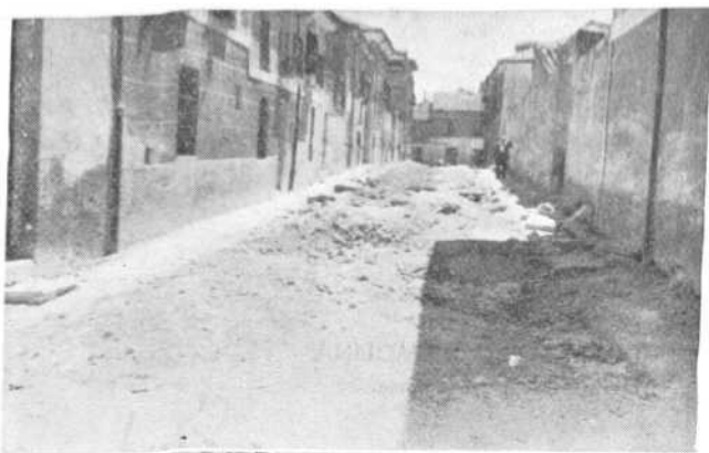
Calle de Acibelas antes y después de ser pavimentada.
