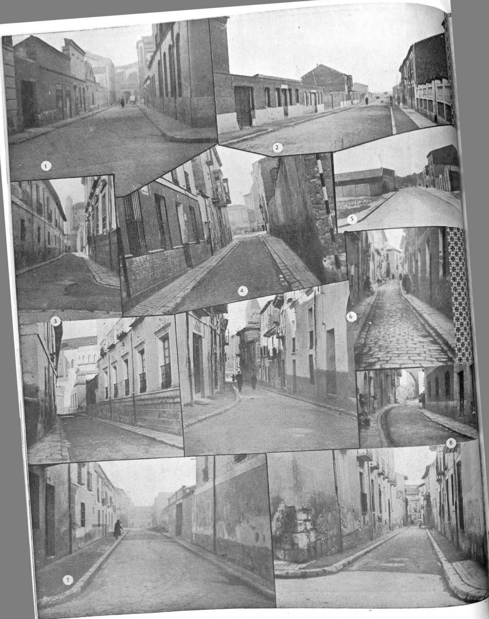
1.-Calle de San Roque, después de pavimentarse. 2.-Calle de Goya, después de pavimentarse. 3.-Calle de Fray Luis de Granada, antes y después de pavimentarse. 4.-Calle de la Galera Vieja, después de pavimentarse. 5.-Calle de Pérez Galdós, después de pavimentarse. 6.-Calle del Marqués del Duero, antes y después de pavimentarse. 7.-Calle de Acibelas, después de pavimentarse. 8.-Calle Nueva de San Martín, antes y después de pavimentarse.
