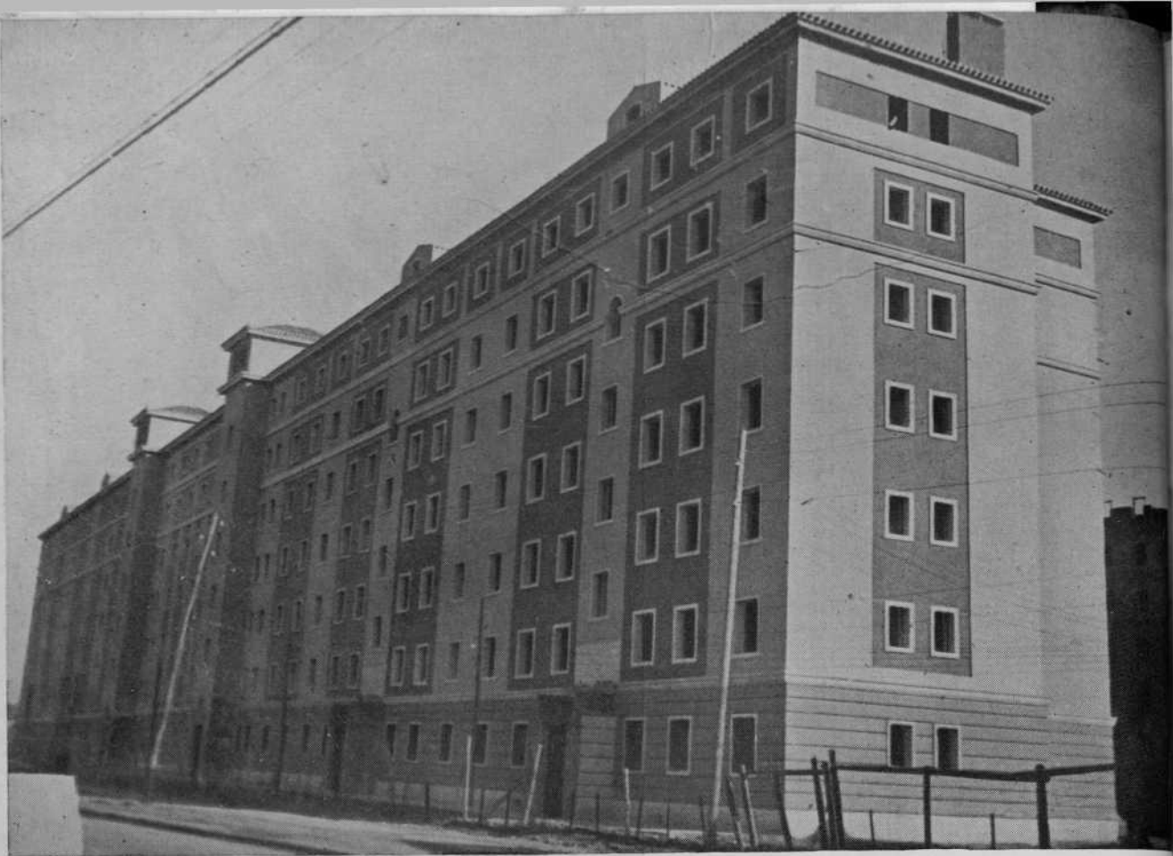
Modificado el plan de urbanización, consiguiéronse facilidades de construcción de grandes bloques de viviendas en la zona que antes había sido destinada a chalets, en el Paseo de Alvarez Taladriz.
