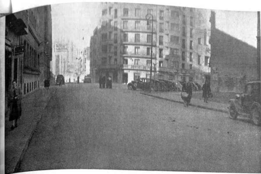
CALLE DE DOÑA MARIA DE MOLINA Después de pavimentarse.
