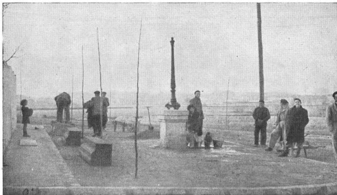
Urbanización de la glorieta en que queda enclavada la nueva fuente.
