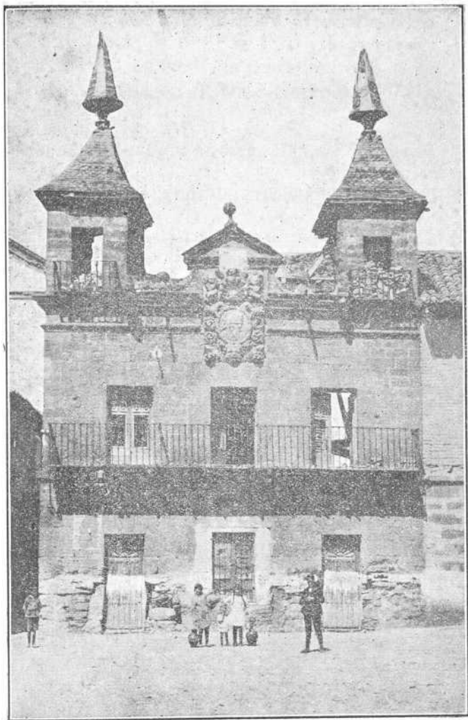
VALDERAS: Casa Consistorial antigua.
