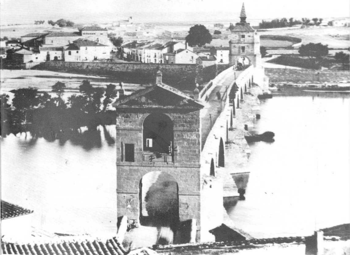
Visión panorámica del viejo puente de piedra con las torres barrocas, anterior a su demolición en 1905.
