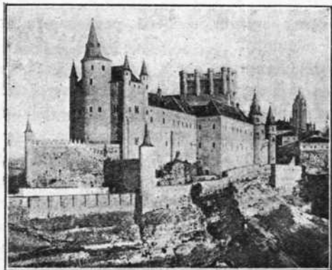
Torre del Homenaje y vista de costado.
