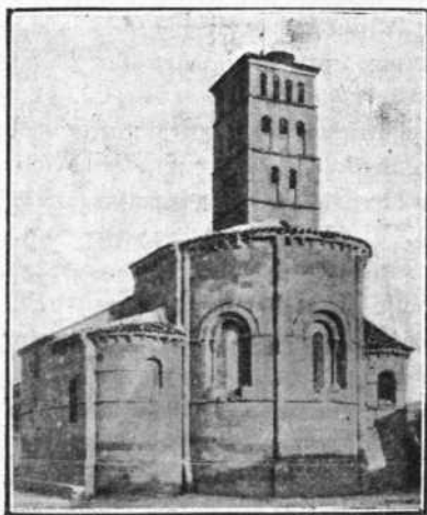
Vista de los ábsides de la bella iglesia de San Andrés.
