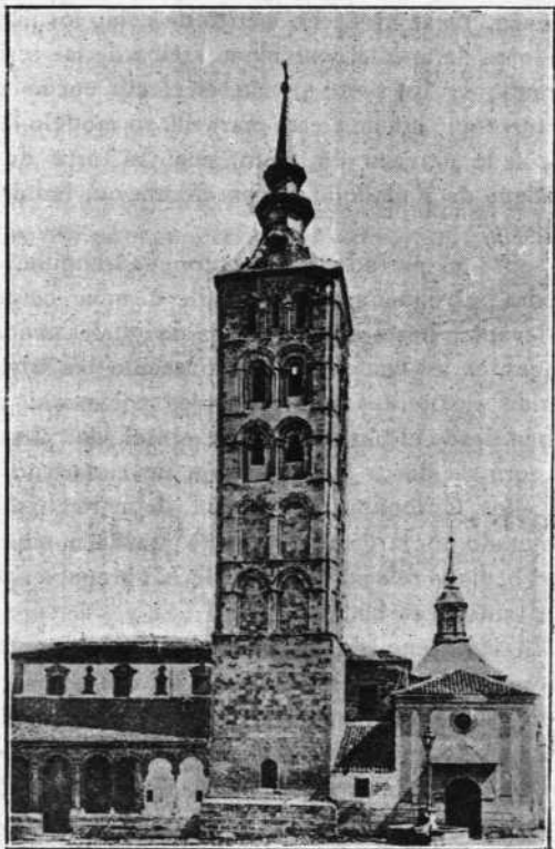
Iglesia de San Esteban, antes de la restauración.
