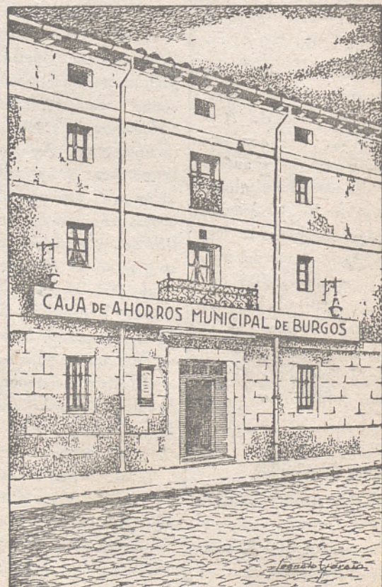
Oficinas donde está instalada la Caja, en Monasterio de Rodilla
