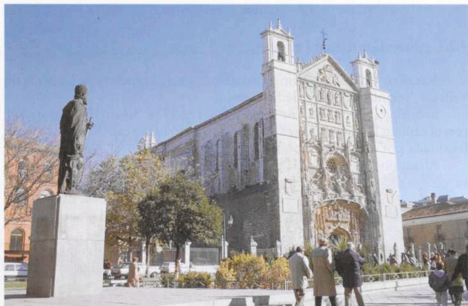
Fachada del convento dominico de San Pablo en Valladolid y escultura de Felipe II.
