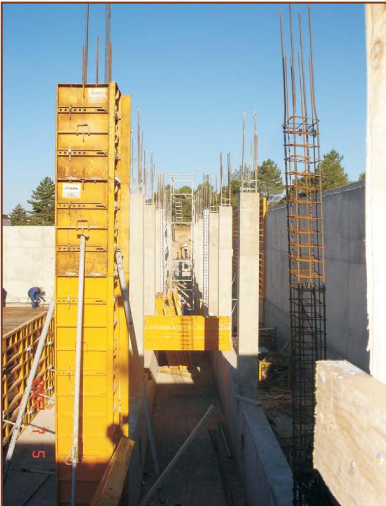
**GANCHO IZADO:** accesorio del sistema de encofrado concebido como elemento auxiliar para el izado mediante grúa.
