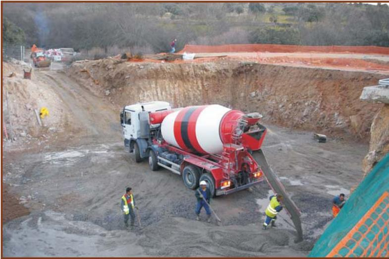
Antes del inicio del vertido del hormigón, el capataz o encargado revisará el buen estado de seguridad de las entibaciones de contención de tierras de los taludes de vaciado que interesan a la zona de muro que se va a hormigonar, para realizar los refuerzos o saneos que fueran necesarios.
