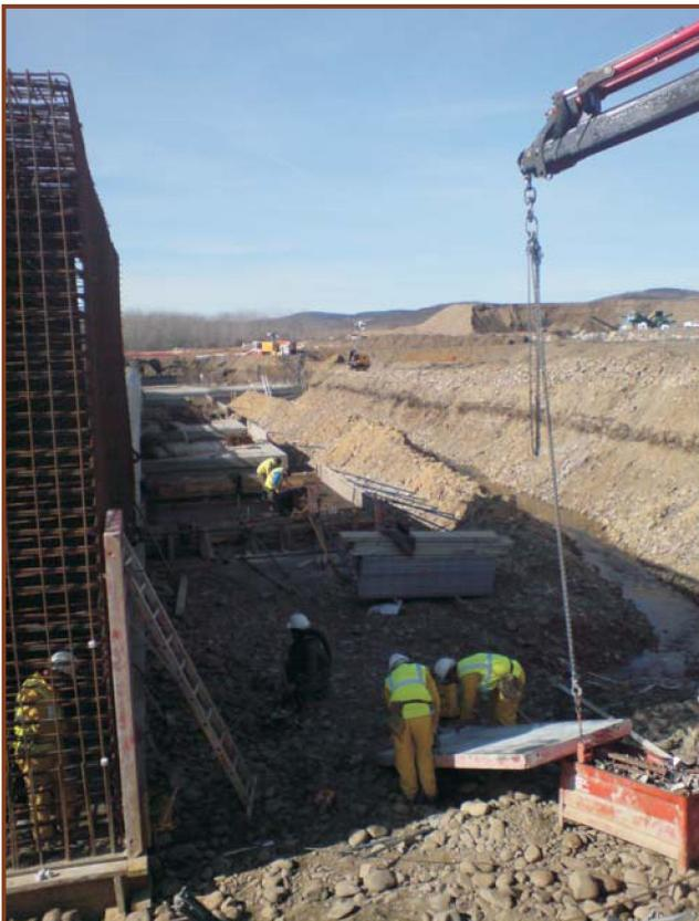
Cada 4 ó 5 puestas se recomienda la limpieza del bastidor metálico del panel, así como la aplicación de desencofrante en el mismo. El desencofrante desempeña un papel importante en la calidad de la superficie del hormigón al poder conseguir que estas superficies estén libres de huecos superficiales y con uniformidad de color.
