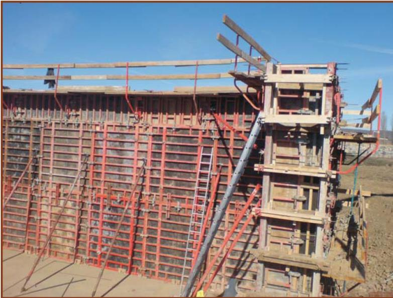
Los trabajos a más de 3,5 metros de altura, desde el punto de operación al suelo, que requieran movimientos o esfuerzos peligrosos para la estabilidad del trabajador, solo se efectuarán si se utiliza un equipo de protección individual anticaídas o se adoptan otras medidas de protección alternativas.
