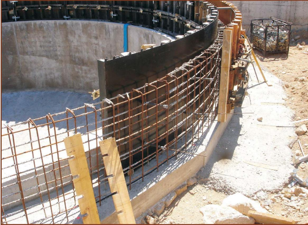
Es importante conocer que la película fenólica del tablero del panel apenas sufre daño con la acción química y abrasiva del hormigón, pero hay que poner atención en el sellado de los agujeros y zonas deterioradas.
