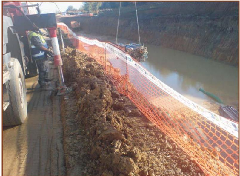
Se extremarán las medidas de seguridad, poniendo especial cuidado para evitar que los aparatos de elevación puedan impactar con las líneas eléctricas aéreas próximas al lugar de trabajo o al camino recorrido por aquellos en sus desplazamientos; deberá mantenerse a la distancia mínima exigida por la normativa para evitar los contactos eléctricos. Las mismas medidas se adoptarán respecto de las cargas suspendidas por dichos aparatos de elevación.
