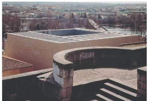
Cubierta del nuevo edificio desde el mirador de San Cipriano. (MZ)
