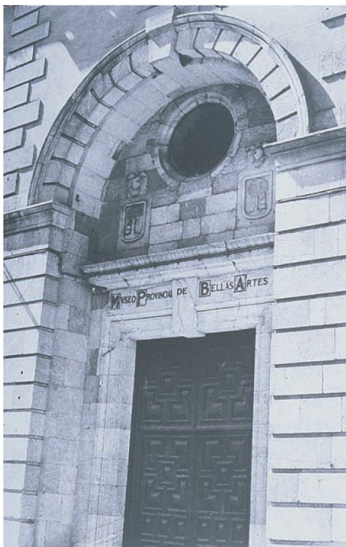
Fachada del antiguo Museo Provincial de Bellas Artes, ubicada en la iglesia del convento de Las Marinas. (MZ)
