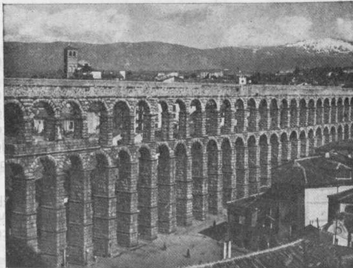
El Acueducto, vista general
