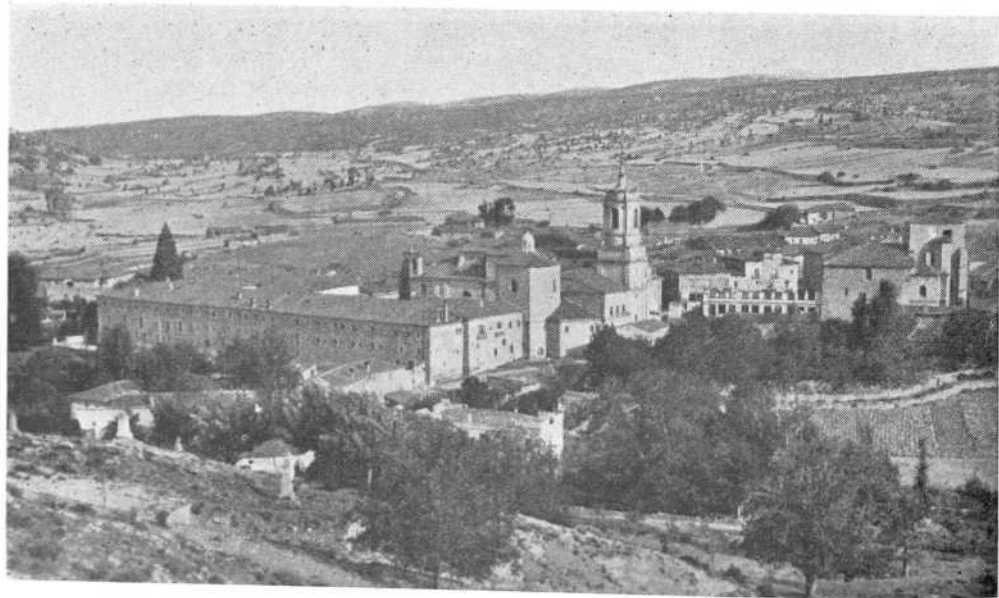
Vista sureste.—Santo Domingo de Silos.
