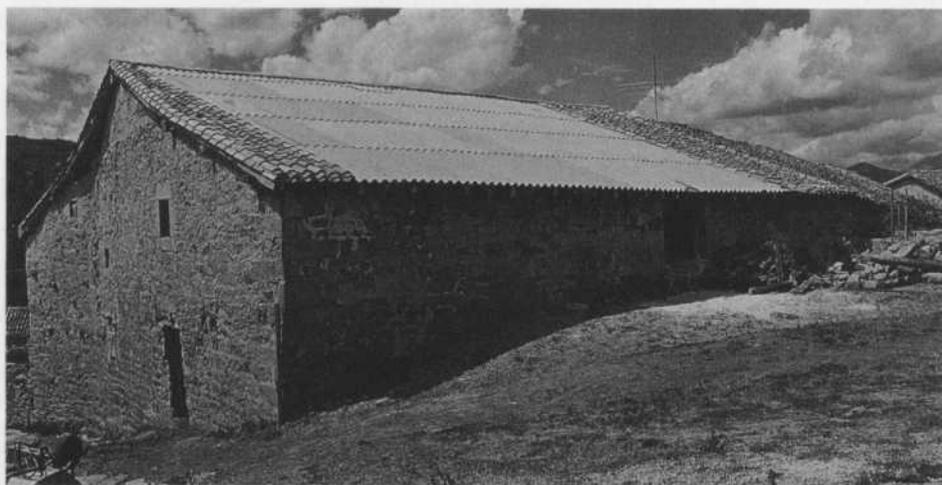
Remodelación del tejado en una construcción tradicional, sustituyendo la teja por uralita.
