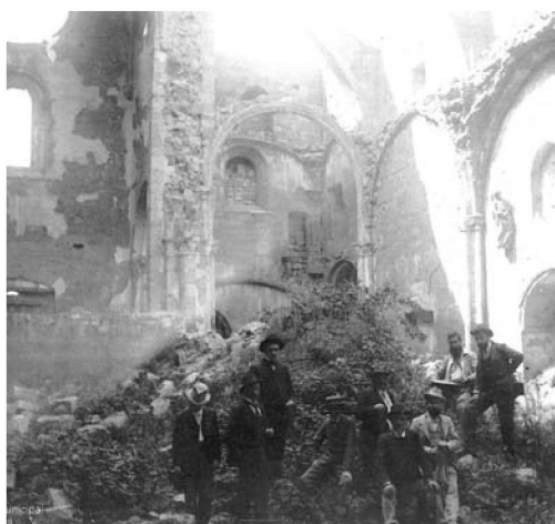
Ruinas de la iglesia de Sasamón en 1902 (AMB, F C- 0536)
